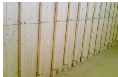
Abbildung 10.10: Federbügel auf BSP- Wand montiert zur Aufnahme der Holzlatten (CLT-Stora Enso) (links)
