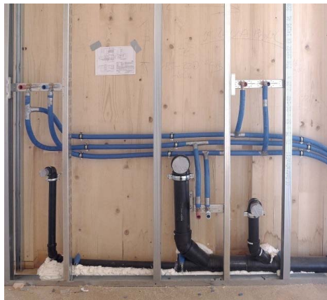
Abbildung 11.11: Wasserführende Leitungen in Installationswand 719 (links)
