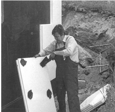
Abbildung 9.10: Punktuelle Verklebung der Perimeterdämmung (Villas Austria GmbH) 651
