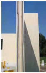
Abbildung 8.28: Kompriband als Fugendichtband (CLT- Stora Enso) (links)
