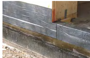
Abbildung 8.30: Abdichtungsbahn VILLAS HYDROSTOP S4 (Villas Austria GmbH) (links)
