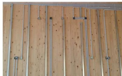
Abbildung 11.10: Wandinstallation von Elektroleitungen in Leerverrohrung 718 (rechts)
