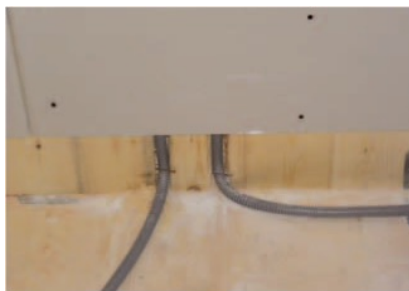
Abbildung 11.5: Elektroleitungen im Fußboden Aufbau 712 (links)
