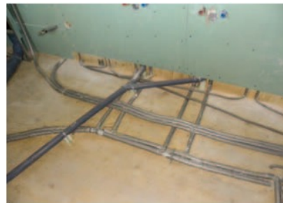
Abbildung 11.5: Elektroleitungen im Fußboden Aufbau 712 (links)
