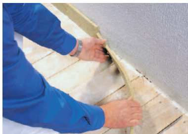
Abbildung 10.15: Anbringen des Mineralwolle-Randdämmstreifen (links)
