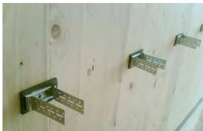
Abbildung 10.10: Federbügel auf BSP- Wand montiert zur Aufnahme der Holzlatten (CLT-Stora Enso) (links)
