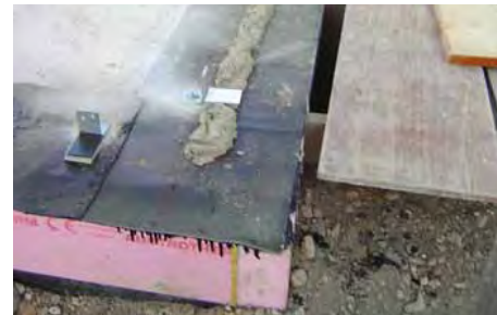
Abbildung 7.2: Sockelausbildung mit Schwellenholz (CLT-Stora Enso) (links)
