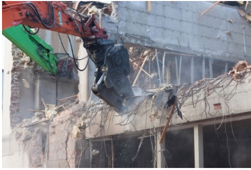
Abbildung 2.7: Typisches Abbruchscenario am Beispiel des Montforthaus, Feldkrich AT der Firma GPS-Gesellschaft für Projektmanagement und Sanierung mbH
