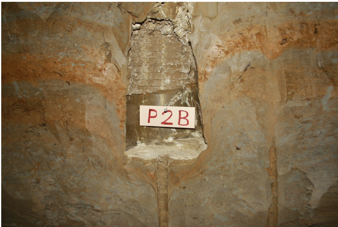
Abbildung 3.47: Profilschnitt des Pfahlspitzbereiches P2B
