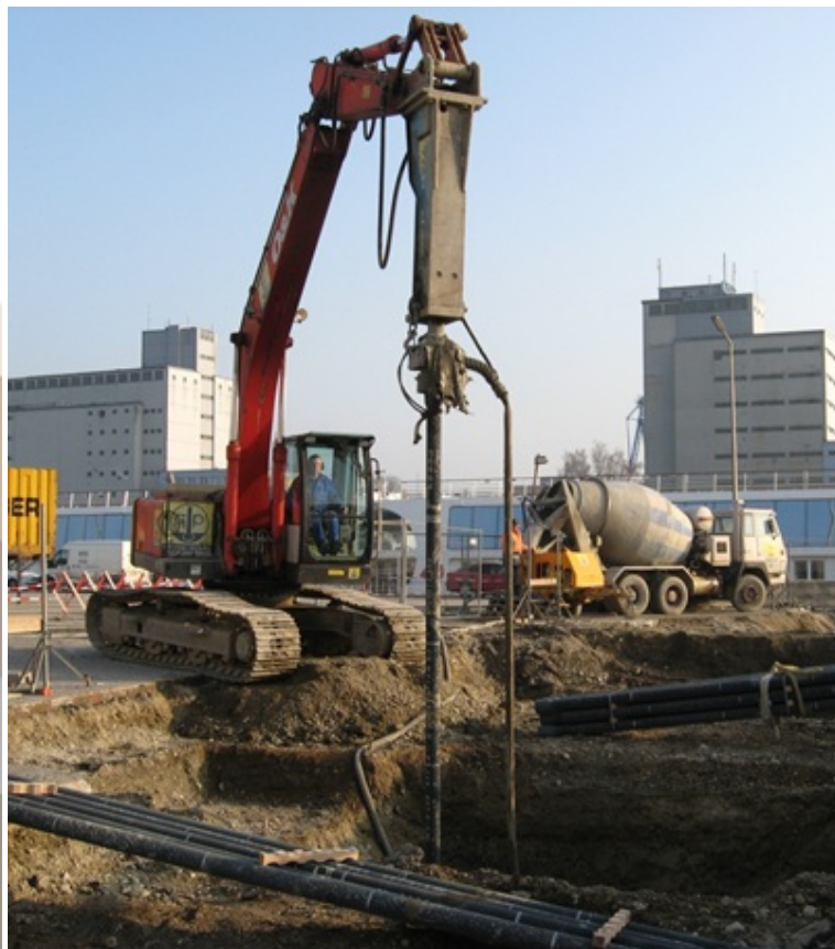
Abbildung 1.16: HLV®-Pfahl System GPS (Pfahlherstellung)
