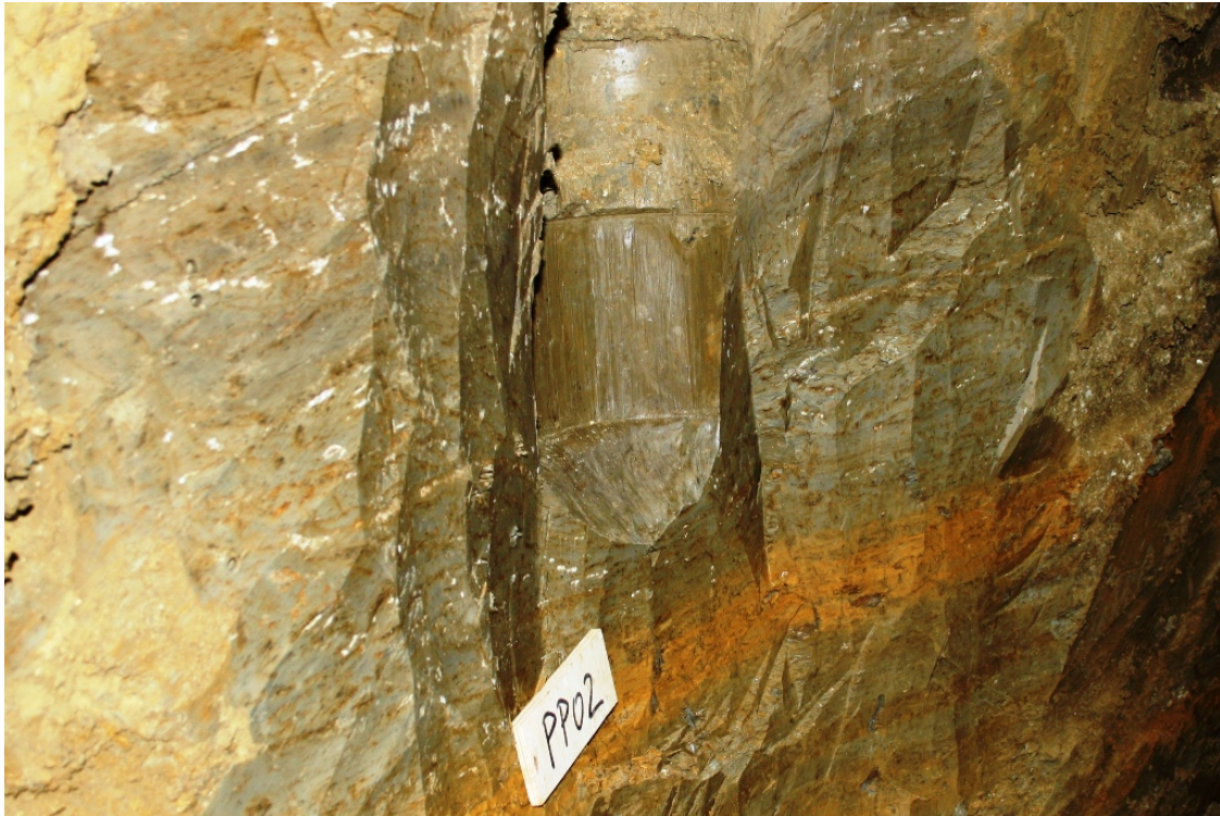
Abbildung 3.68: Das freigelegten Pfahlprofil PP02, nach Entnahmen des Probenstückes A (Frontalansicht).
