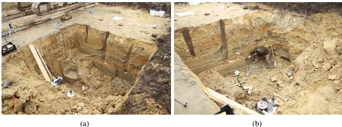
Abbildung 3.27: Die Baugrube der Pfahlfreilegung aus verschiedenen Perspektiven
