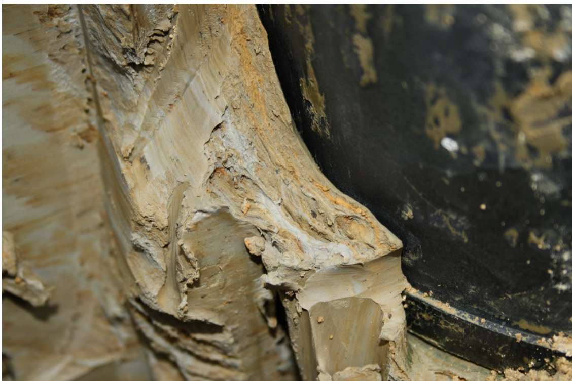
Abbildung 3.33: Großaufnahme des Bereiches neben einer Fußkappe
