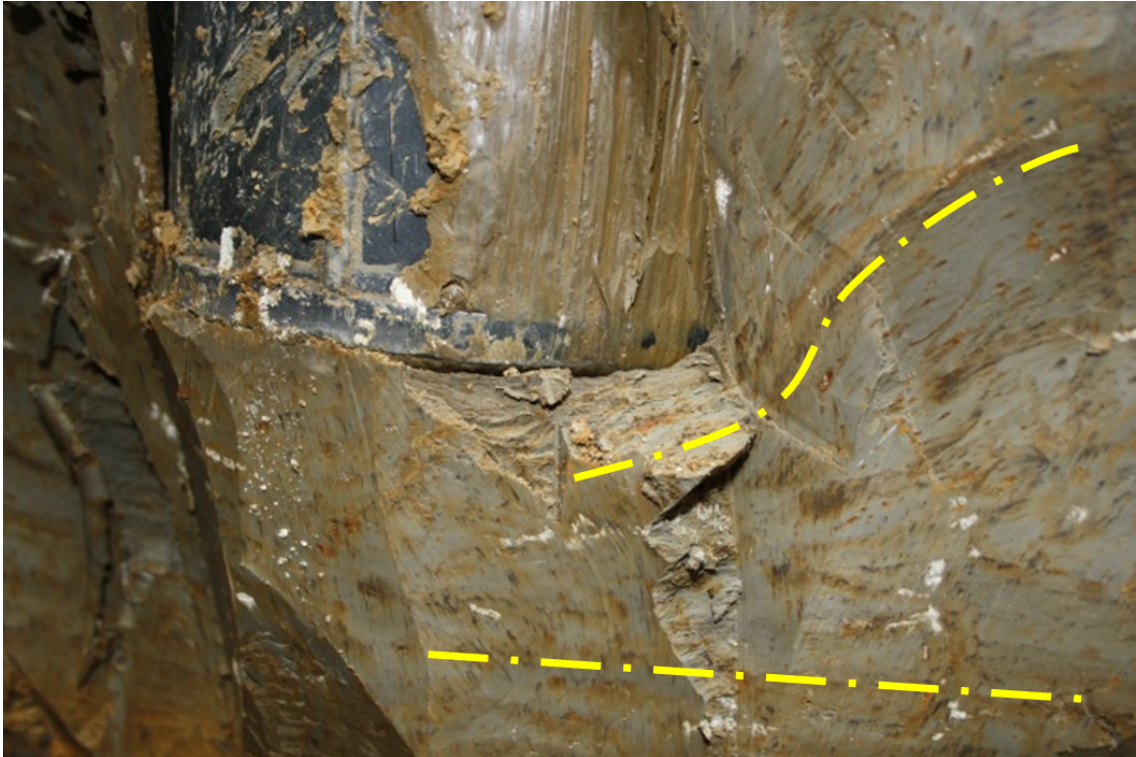
Abbildung 3.63: Großaufnahme der Teilweise freigelegten Pfahlspitze PP02
