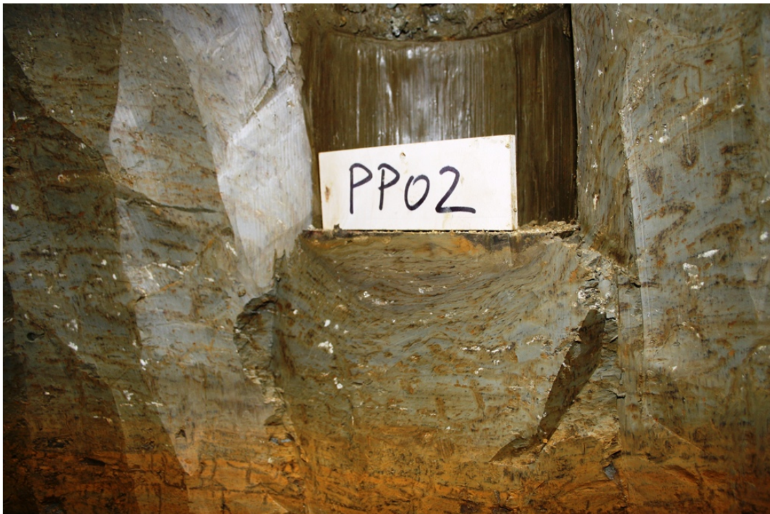
Abbildung 3.66: Großaufnahmen des Pfahlspitzenprofils PP02
