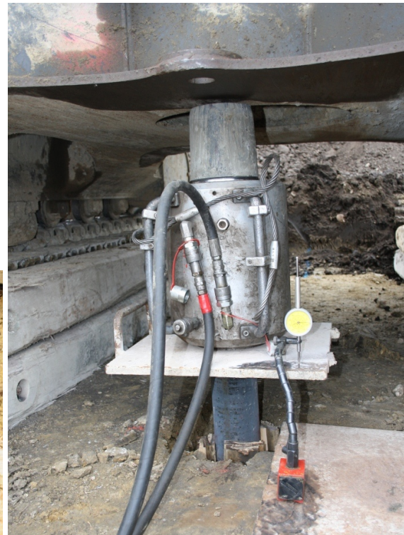
Abbildung 3.18: Aufbau der hydraulischen Presse für die Probebelastung mit Todlast
