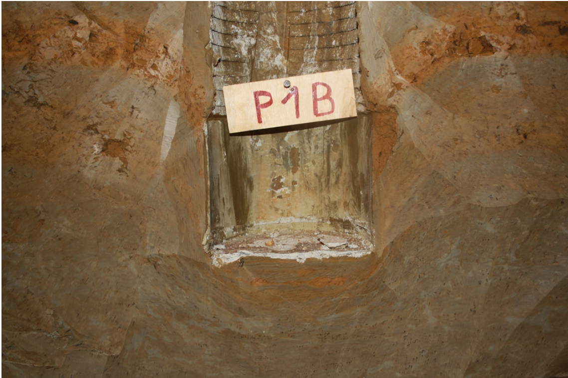
Abbildung 3.54: Großaufnahme der freigelegte Pfahlspitze des Pfahles P1B
