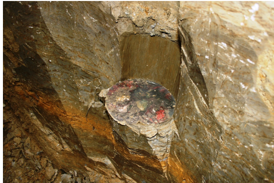
Abbildung 3.65: Der Pfahlspitzenbereich PP02 nach Entnahme der Fußkappe.
