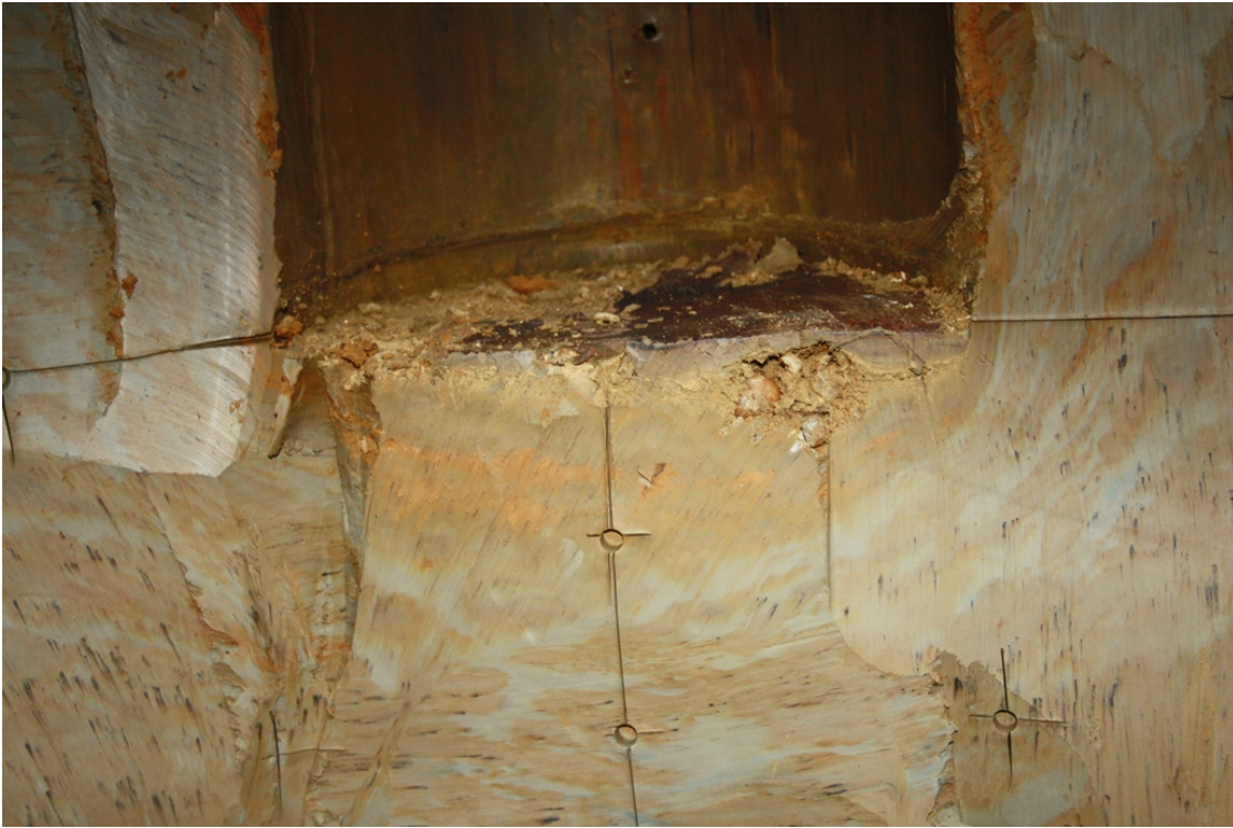
Abbildung 3.35: Profilschnitt des Pfahlspitzbereiches P4B (Großaufnahmen)
