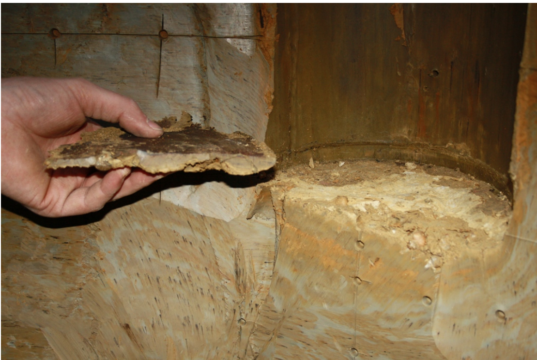
Abbildung 3.36: Profilschnitt des Pfahlspitzbereiches P4B (Großaufnahmen)
