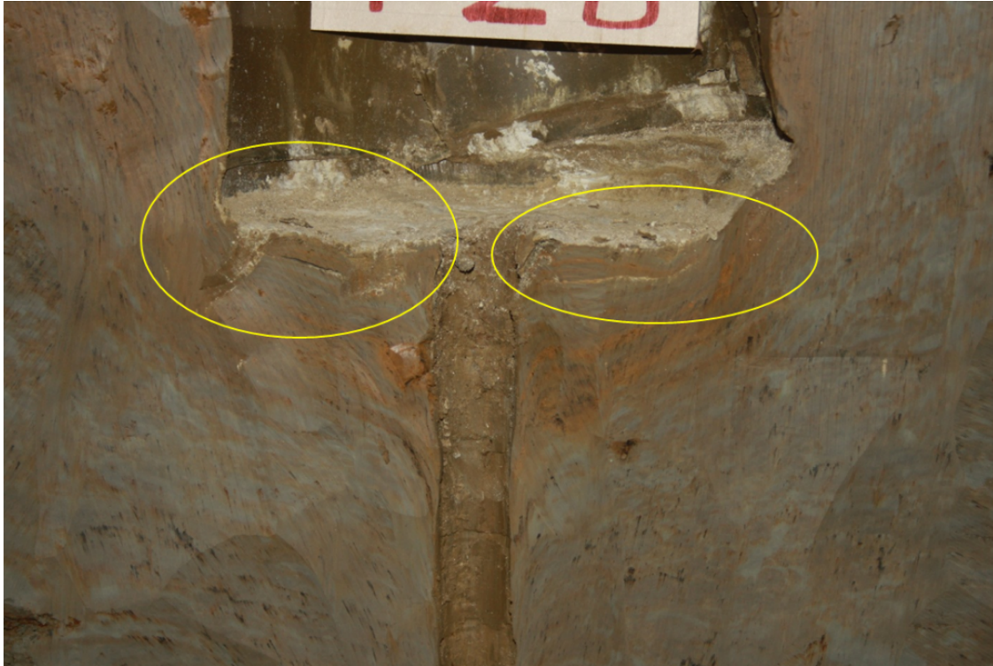
Abbildung 3.48: Großaufnahme des Pfahlspitzebereiches P2B - Verformungen und Einflussbereich der Pfahlherstellung und der Rammsondierung
