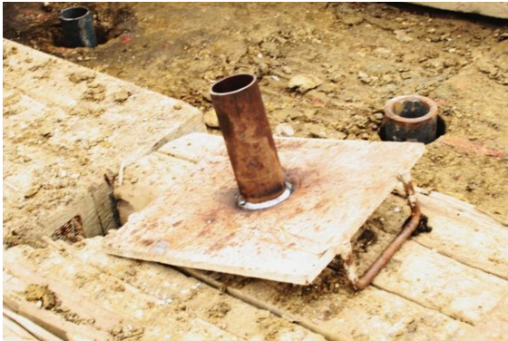
Abbildung 3.17: Lastverteilende Stahlplatte mit angeschweißtem Rohrstück
