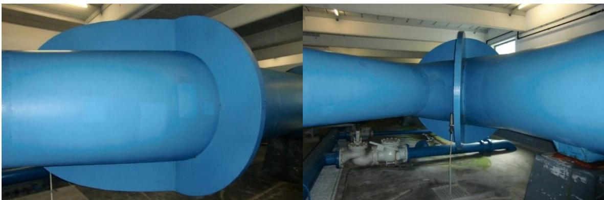
Abbildung 66: Foto des Abzweigers 28 mit blauem Korrosionsschutz
