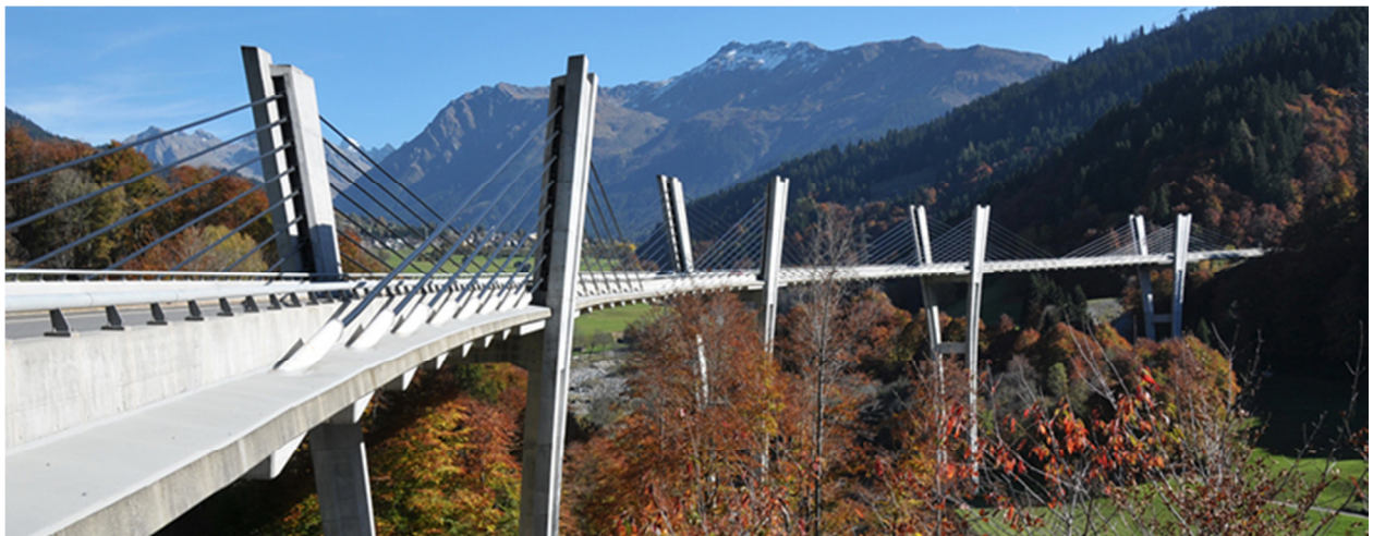
ABBILDUNG 1: BEISPIEL EINER INTEGRAL AUSGEFÜHRTEN BRÜCKE (SUNNIBERGBRÜCKE) [1]
