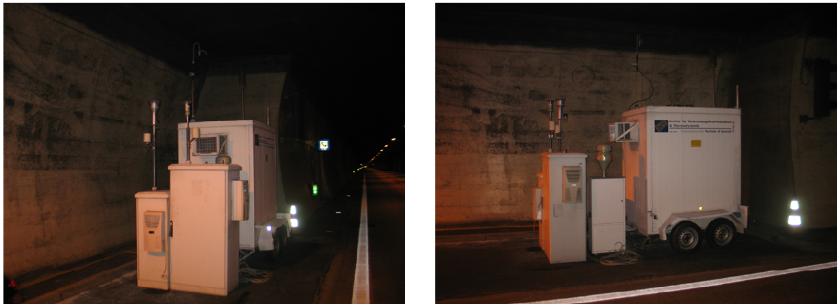
Abbildung 12: Verwendete Messcontainer und DIGITEL der Messung 2013
