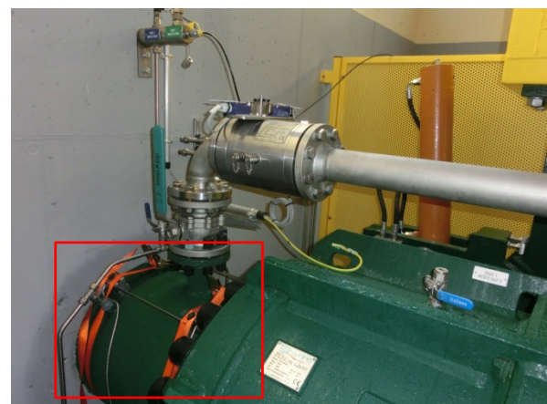
Abbildung 6-4: Montageposition der „Clamp-On-Sensoren“ zur Vergleichsmessung
