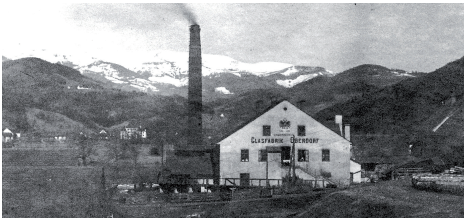
Glasfabrik im November 1914
