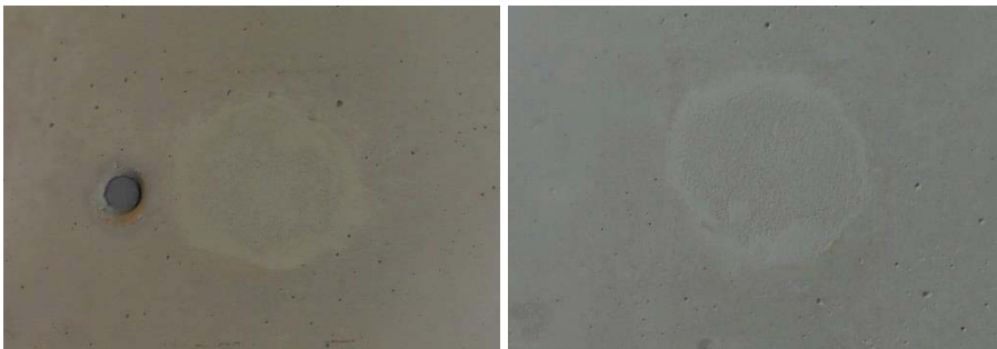
Abbildung 3.32 Sanierte Stellen im Stiegenhaus
