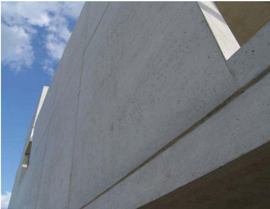
Abbildung 3.10 Arbeitsfuge AF2 (Ausführung mit Trapezleiste)
