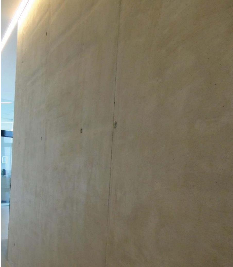
Abbildung 3.24 Gesamteindruck in der Eingangshalle
