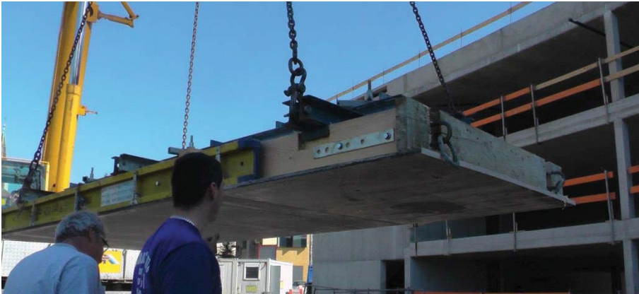
Abbildung 4.109 Schalungsaufdoppelung (Schritt 4: Montieren der Schalhaut)
