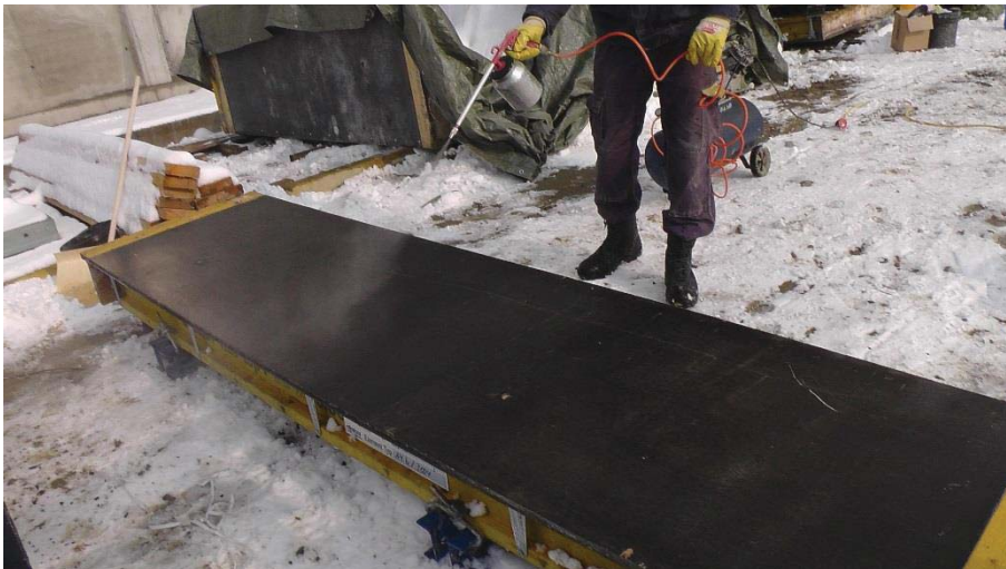
Abbildung 4.20 Eisfreie Schalung im 11. OG, Bauteil 1
