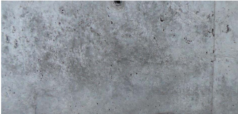
Abbildung 4.31 Dunkle Flecken im 11. OG, Bauteil 1
