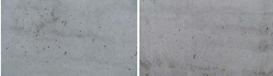
Abbildung 4.28 Porigkeit im 11. OG, Bauteil 1
