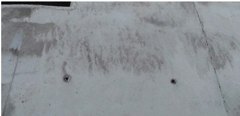
Abbildung 4.32 Farb(un)gleichheit im 11. OG, Bauteil 1
