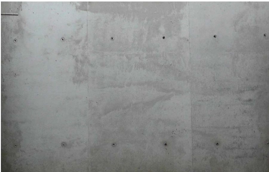
Abbildung 4.42 Farbgleichheit im 11. OG, Bauteil 2
