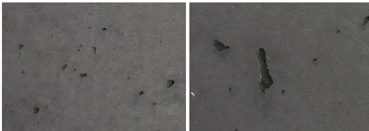
Abbildung 4.16 Porigkeit im 10. OG, Bauteil 2
