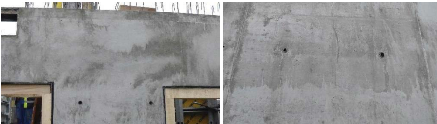
Abbildung 4.29 Farbgleichheit im 11. OG, Bauteil 1
