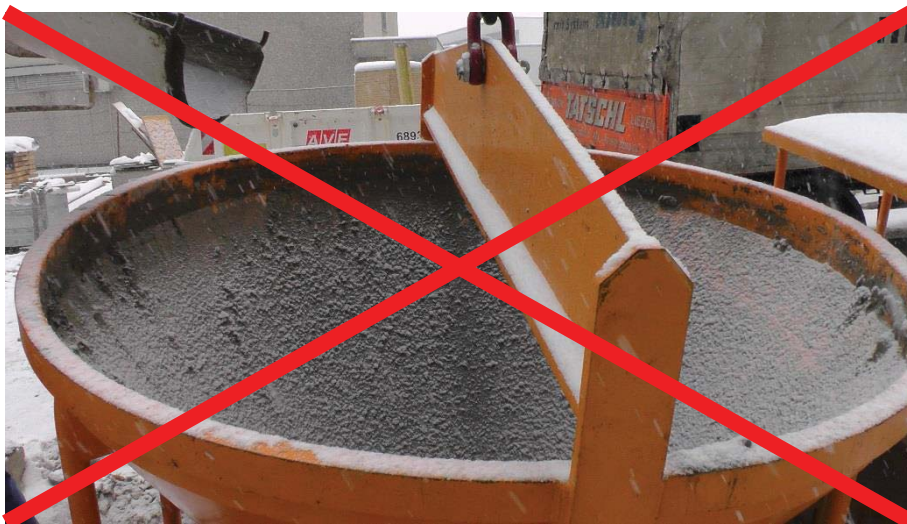
Abbildung 5.43 Schneebedeckter Betonkübel
