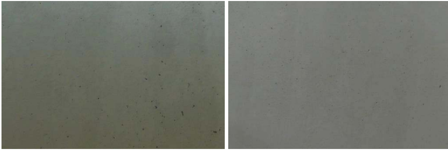
Abbildung 3.27 Porigkeit im Stiegenhaus
