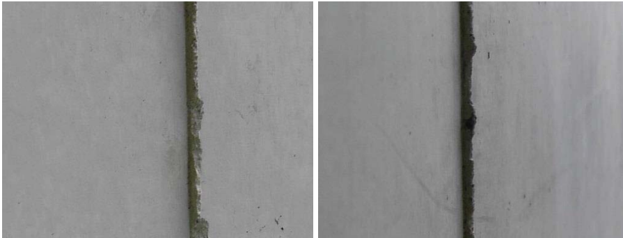
Abbildung 4.81 Versatz am Elementstoß
