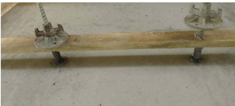
Abbildung 5.47 Distanzierung des Kantenschutzes durch Abstandhalter (ideal)
