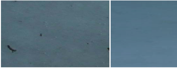
Abbildung 4.105 Porigkeit im 13.OG, Bauteil 2
