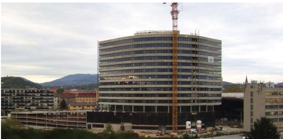
Abbildung 3.2 SMC während der Bauausführung
