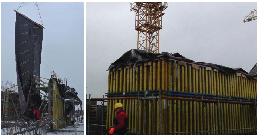
Abbildung 5.45 Abdecken der Schalung
