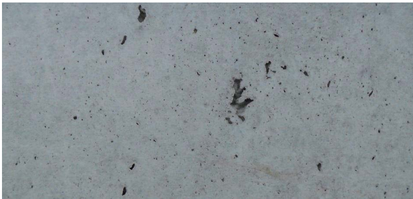
Abbildung 4.35 Hohe Anzahl an Poren im 11. OG, Bauteil 1
