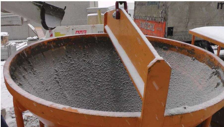
Abbildung 4.24 Schneebedeckter Betonkübel
