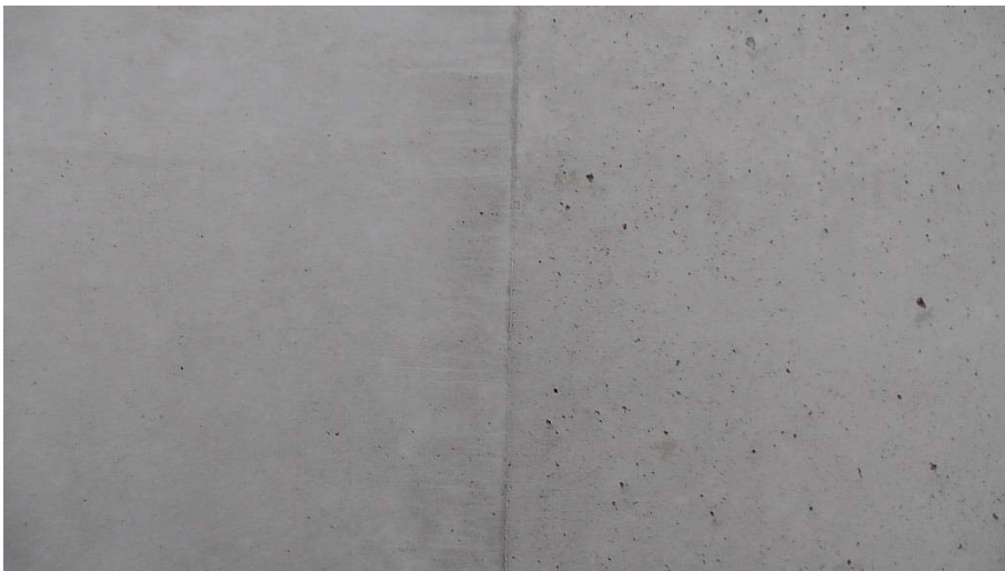
Abbildung 4.38 Porigkeit der Zwischenwand (links: neue Schalhaut, rechts: alte Schalhaut)
