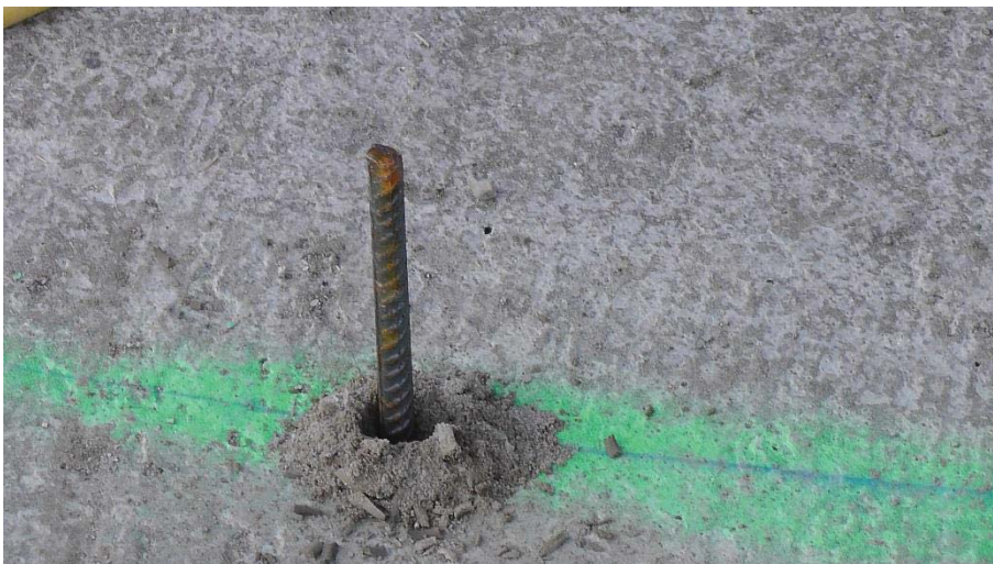
Abbildung 3.39 Markierung der Schalungsposition
