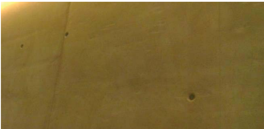
Abbildung 3.23 Porigkeit in der Eingangshalle
