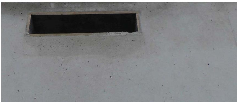
Abbildung 4.86 Porigkeit im 12.OG, Bauteil 2
