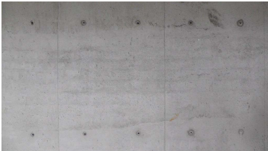
Abbildung 5.19 Abzeichnen der Bewehrung
