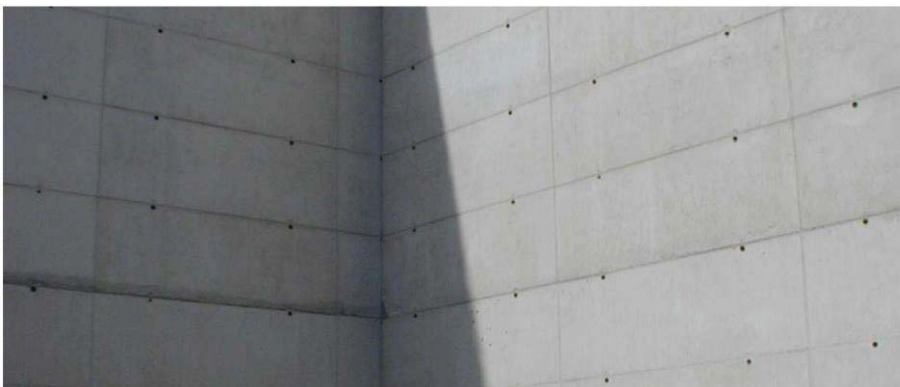
Abbildung 3.19 Systemrahmenschalung SY1
