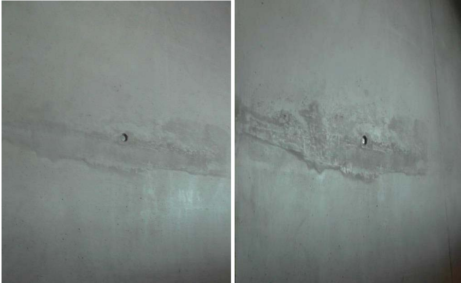
Abbildung 3.29 Elementstoß im Stiegenhaus
