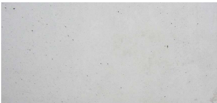
Abbildung 4.94 Porigkeit im 13.OG, Bauteil 1
