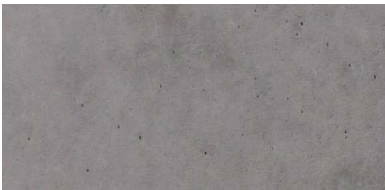
Abbildung 4.115 Porigkeit im 14.OG, Bauteil 2
