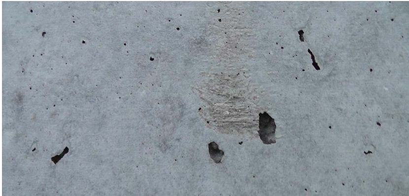
Abbildung 4.34 Größe der Poren im 11. OG, Bauteil 1
