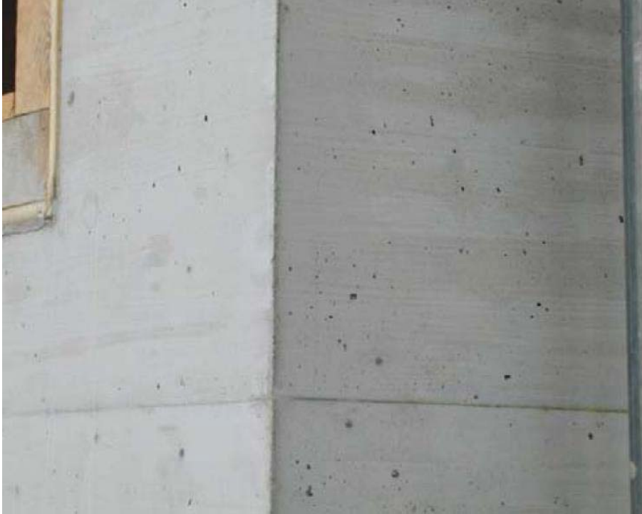
Abbildung 3.13 Kantenausbildung K2
