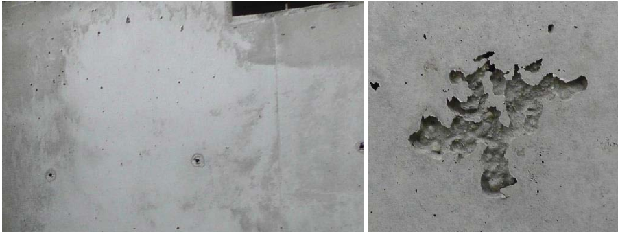
Abbildung 4.41 Porigkeit im 11. OG, Bauteil 2
