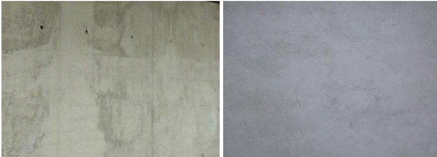
Abbildung 4.3 Farbgleichheit im 10. OG, Bauteil 1
