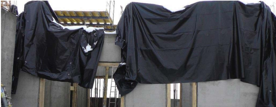
Abbildung 4.11 Abdeckung der Bewehrung bei Schneefall
