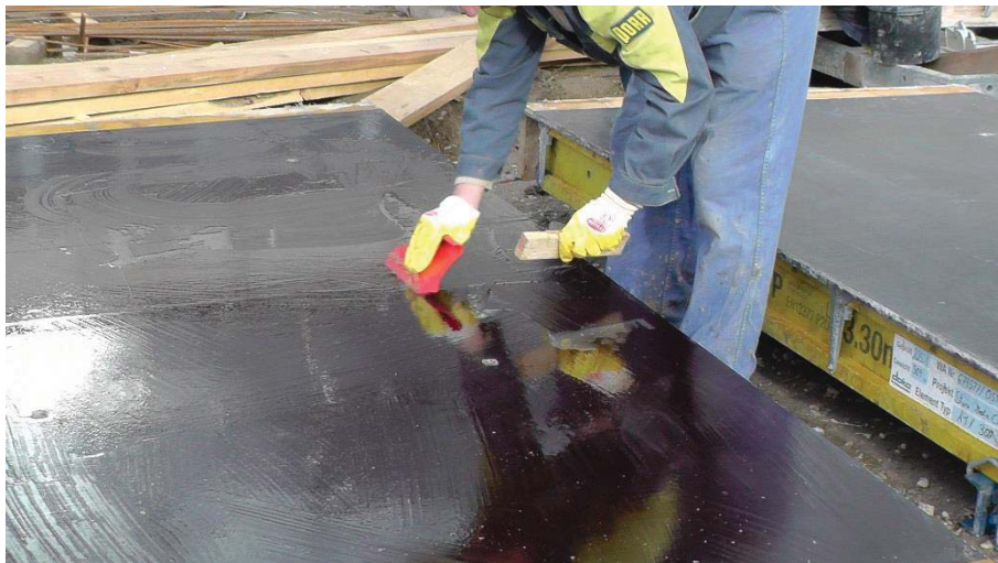
Abbildung 5.41 Reinigung der Schalhaut mit Kunststoffspachtel und Kantholz
