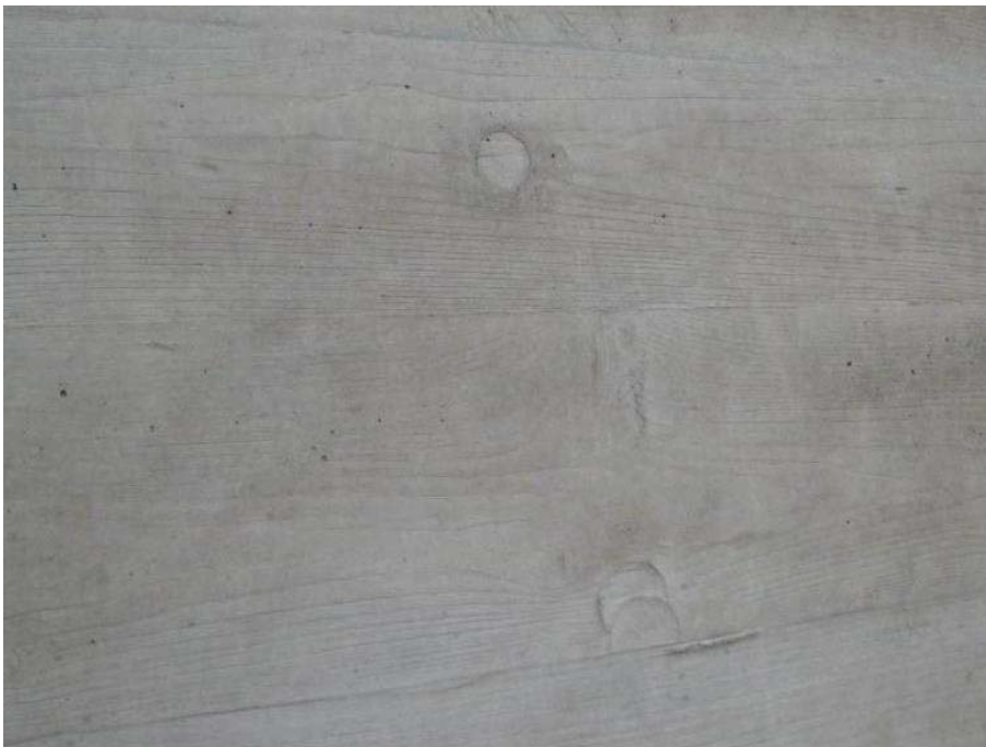
Abbildung 3.18 Schalhautzustand SZ2
