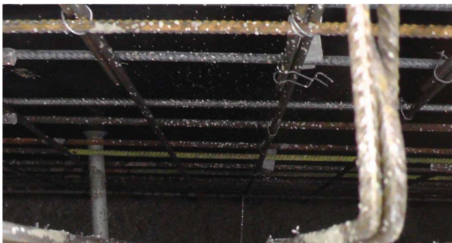
Abbildung 5.40 Markierung der Schüttlagen an der Bewehrung
