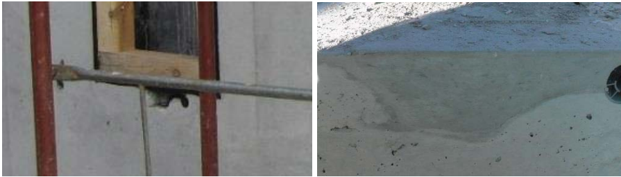
Abbildung 4.103 Fensterdurchbruch im 13.OG, Bauteil 2
