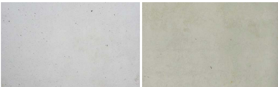
Abbildung 4.90 Porigkeit im 13. OG, Bauteil 1
