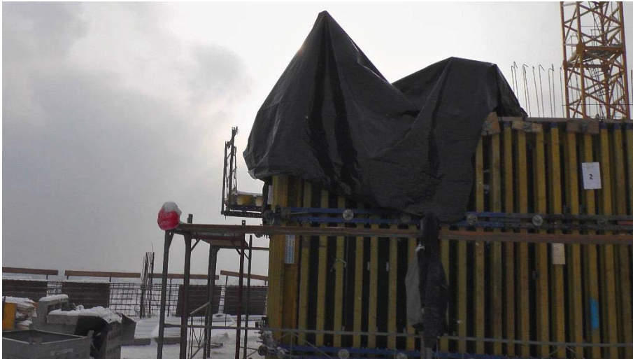
Abbildung 4.21 Abgedeckte Bewehrung während des Schalvorganges
