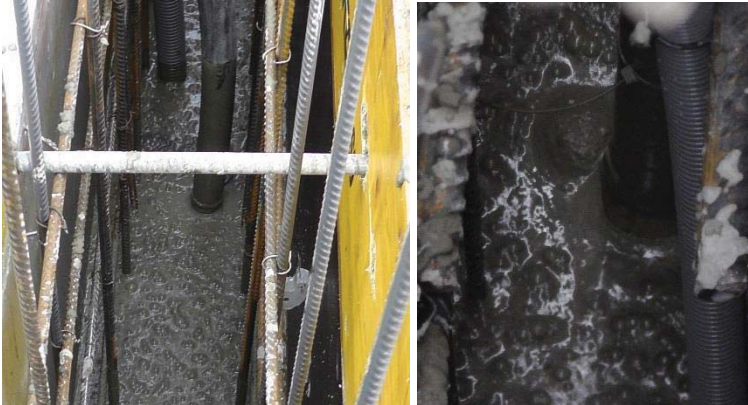
Abbildung 4.4 Kabelbinder an Rüttelflasche
