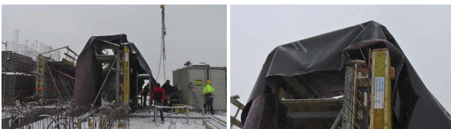
Abbildung 4.27 Abdecken der Sichtbetonwand im 11. OG, Bauteil 1
