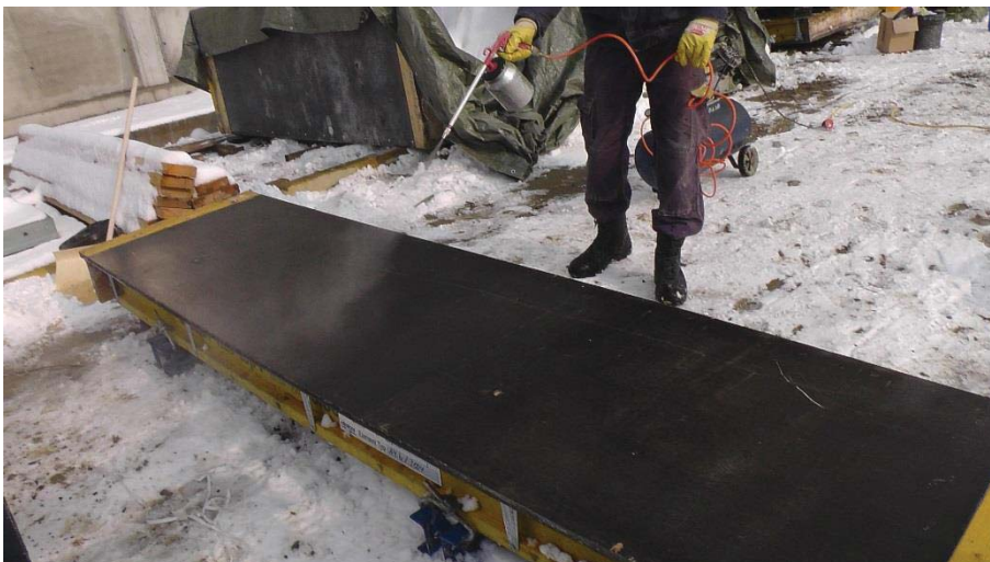
Abbildung 5.22 Eisfreie Schalhaut bei einer Außentemperatur von 0 °C
