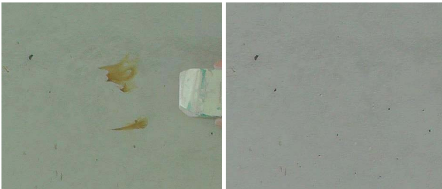
Abbildung 6.2 Erfolgreiche Entfernung von Rostflecken mit einem Bimsstein
