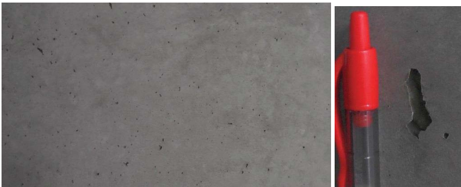
Abbildung 4.12 Porigkeit im 10. OG, Bauteil 2
