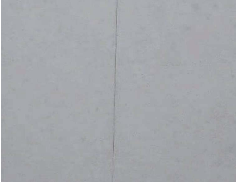
Abbildung 3.9 Schalhautstoß HS2
