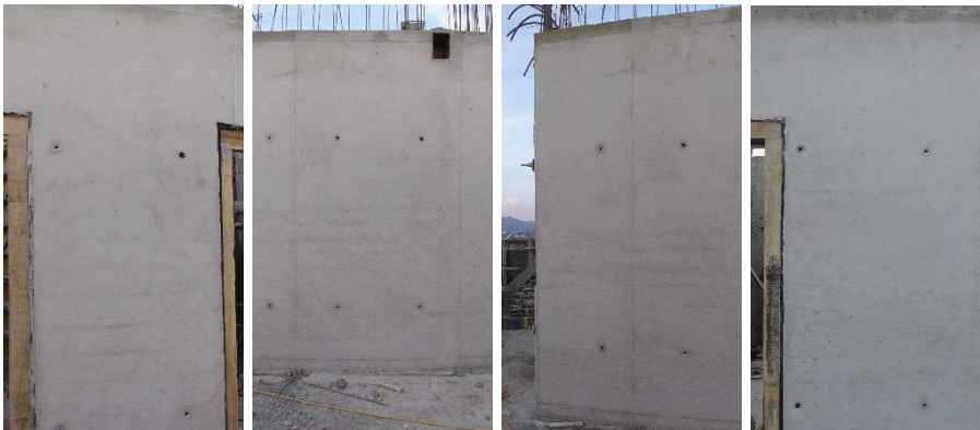
Abbildung 4.80 Farbgleichheit im 12. OG, Bauteil 2
