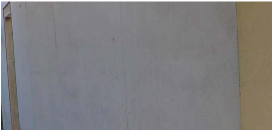
Abbildung 4.102 Farbgleichheit im 13. OG, Bauteil 2
