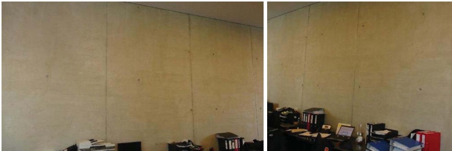
Abbildung 3.22 Farbgleichheit in der Eingangshalle
