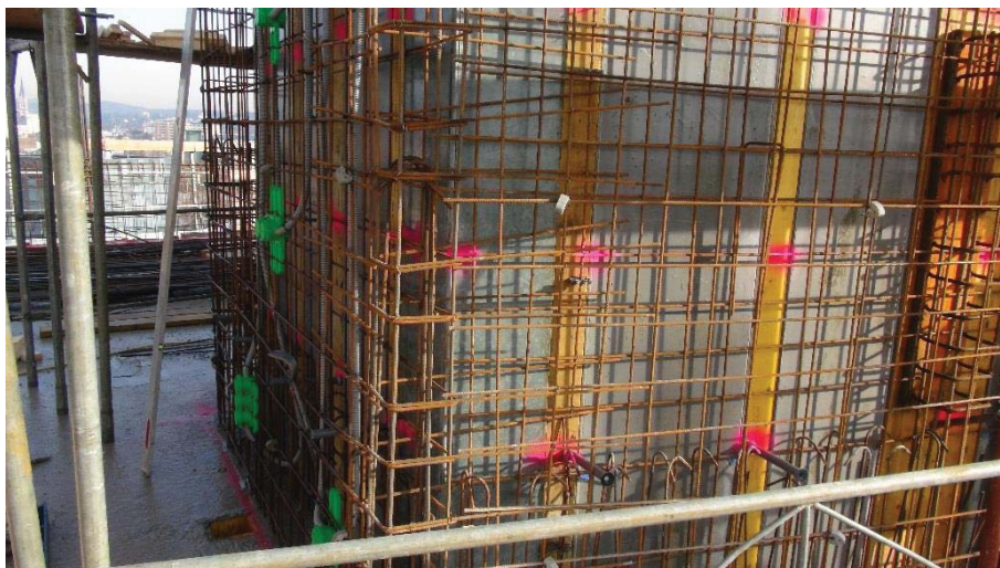
Abbildung 5.39 Markierung der Schüttlagen an der Stellschalung
