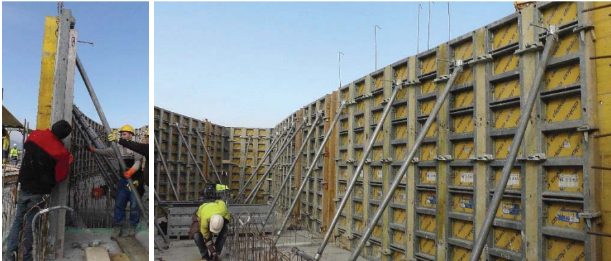
Abbildung 4.76 Stellen der Innenschalung
