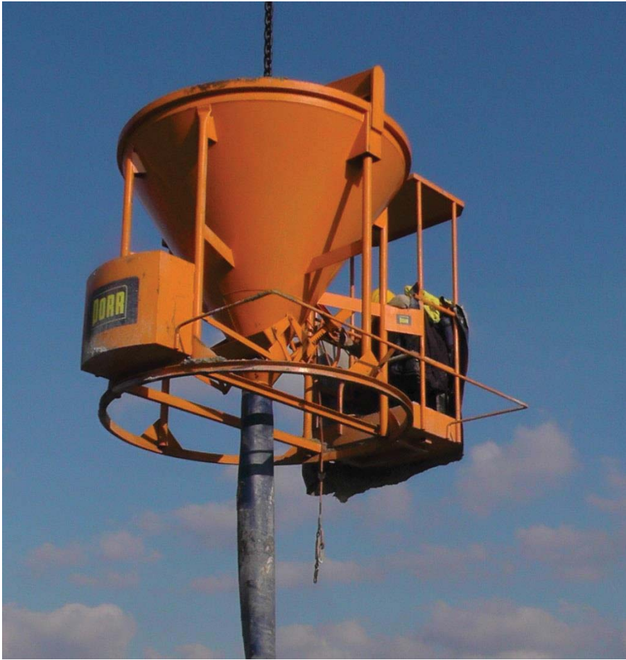
Abbildung 3.42 Krankübel samt flexibler Einbringschlauch
