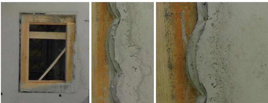
Abbildung 4.92 Fensterdurchbruch im 13. OG, Bauteil 1
