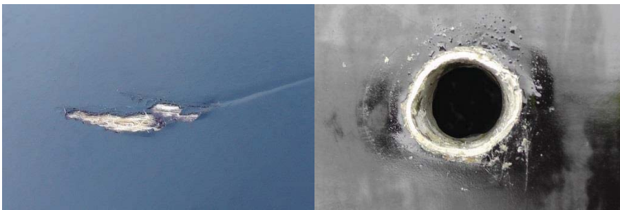
Abbildung 4.89 Schäden an der Schalung
