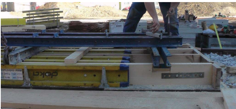
Abbildung 4.108 Schalungsaufdoppelung (Schritt 3: Aussteifen mit Doppel-C-Profilen)
