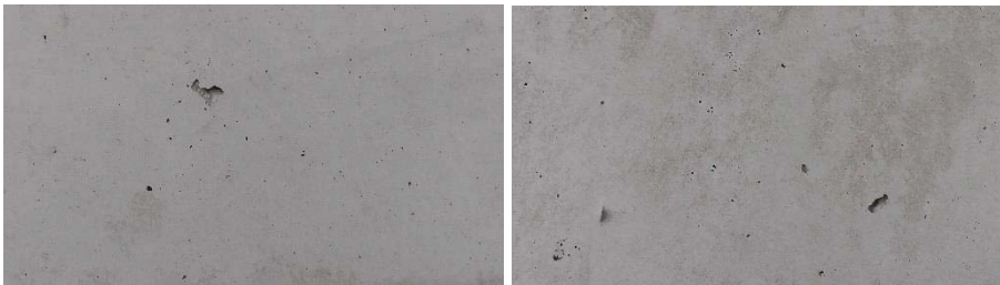
Abbildung 4.79 Porigkeit im 12. OG, Bauteil 2
