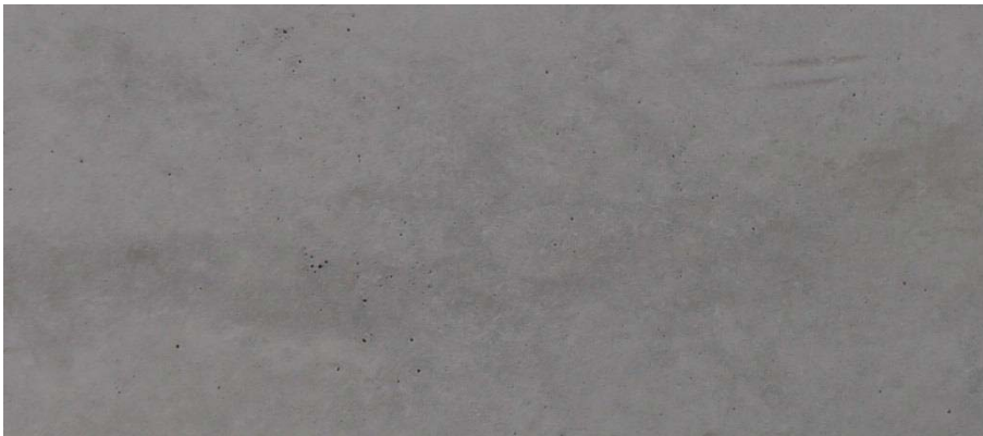
Abbildung 4.111 Porigkeit im 14. OG, Bauteil 2
