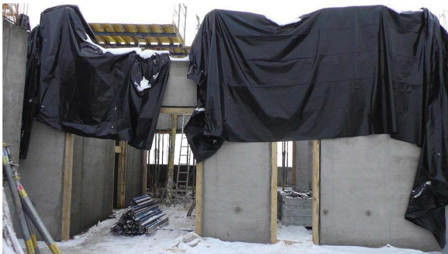
Abbildung 5.49 Abdeckung der Bewehrung bei Regen bzw. Schneefall
