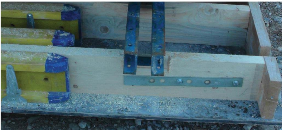
Abbildung 4.110 Schalungsaufdoppelung (Schritt 5: Ergebnis)
