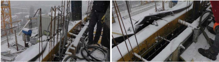
Abbildung 4.25 Schneefall während der Betonage im 11. OG, Bauteil 1
