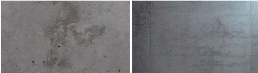
Abbildung 4.13 Farbgleichheit im 10. OG, Bauteil 2
