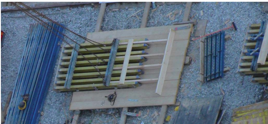
Abbildung 4.107 Schalungsaufdoppelung (Schritt 2: Aufstocken des Grundträgergerüsts)
