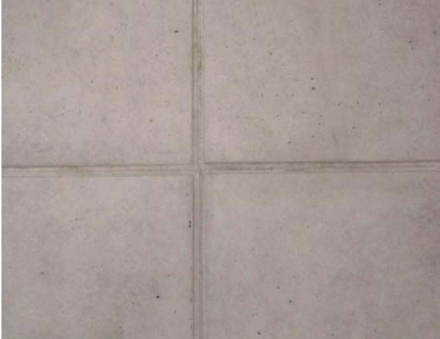
Abbildung 3.17 Befestigungsart der Schalhaut BA2 (nicht sichtbare Befestigung)
