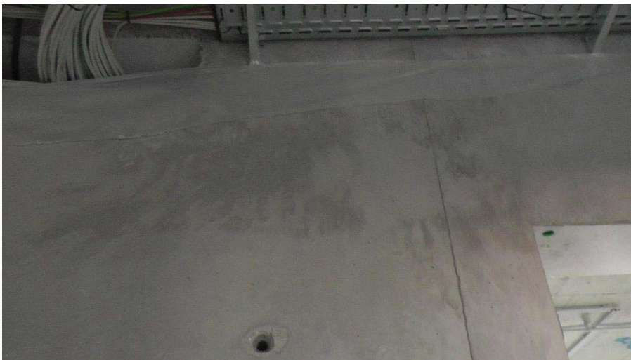
Abbildung 6.4 Sichtbetonwand vor der Reinigung mit Universalschleifgerät
