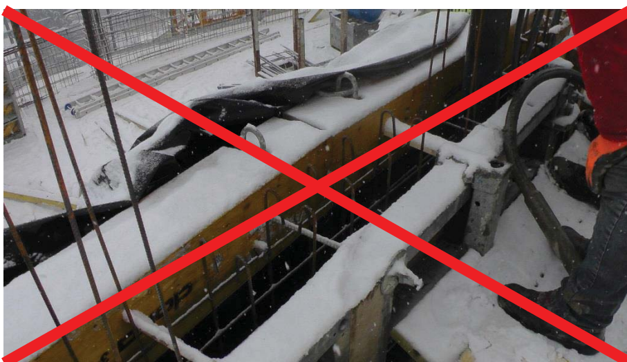
Abbildung 5.44 Schneebedeckte Schalung
