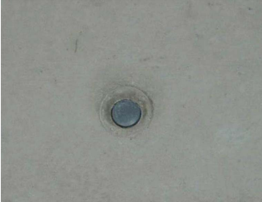
Abbildung 3.15 Verschluss des Ankerloches AV1 (mit Kunststoffstopfen)
