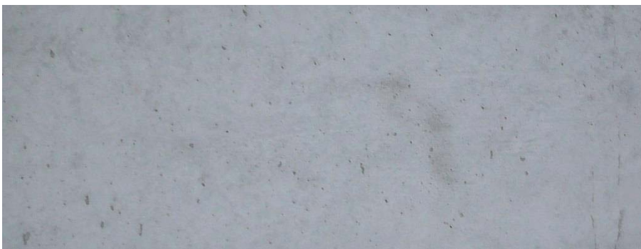
Abbildung 4.2 Porigkeit im 10. OG, Bauteil 1
