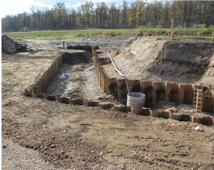
Abb. 12 Spundwand Auslaufbauwerk ARA Gössendorf mit Schotterkegel
