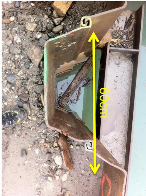
Abb. 10 Spundwand mit I-Trägern Auslaufbauwerk Gössendorf
