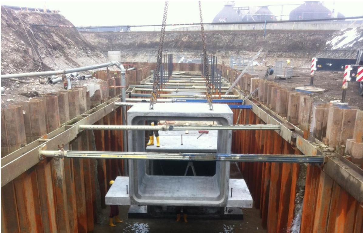
Abb. 11 variable Spundwandaussteifung
