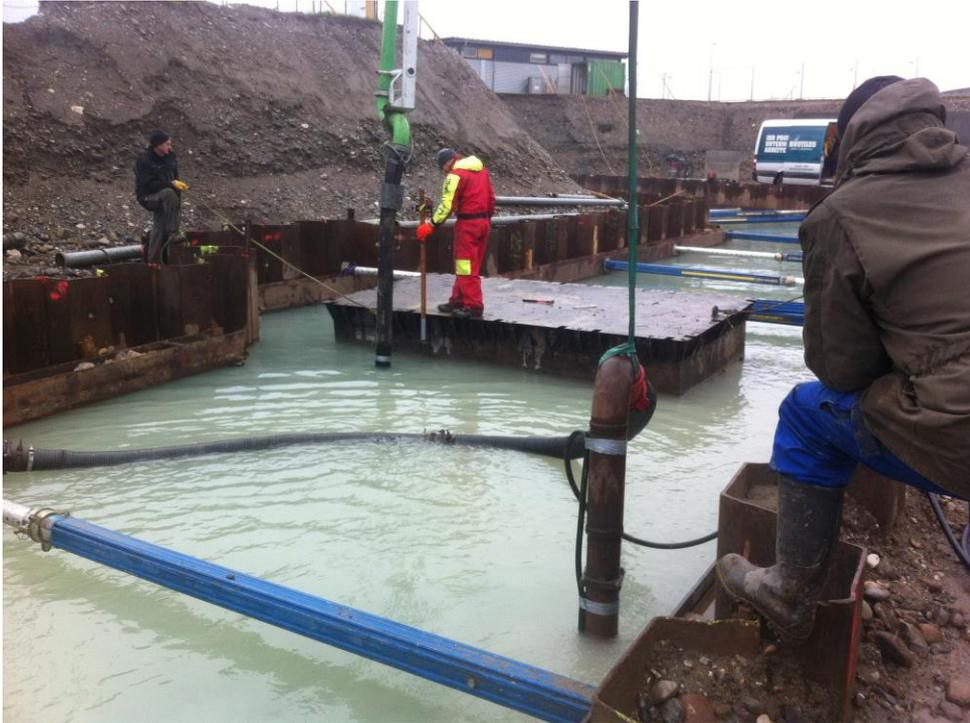
Abb. 15 Unterwasserbetonage ARA Gössendorf 9.12.2014
