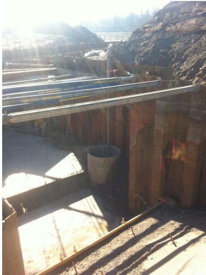
Abb. 9 Pumpensumpf im Bereich 3
