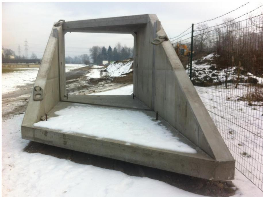
Abb. 54 Fertigteil 13 Auslauf mit Schiene für Dammbalken
