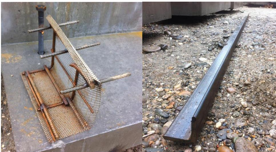
Abb. 16 Abschalgitter (li) und Stahlprofil (re) zum Abschalen der UWBS
