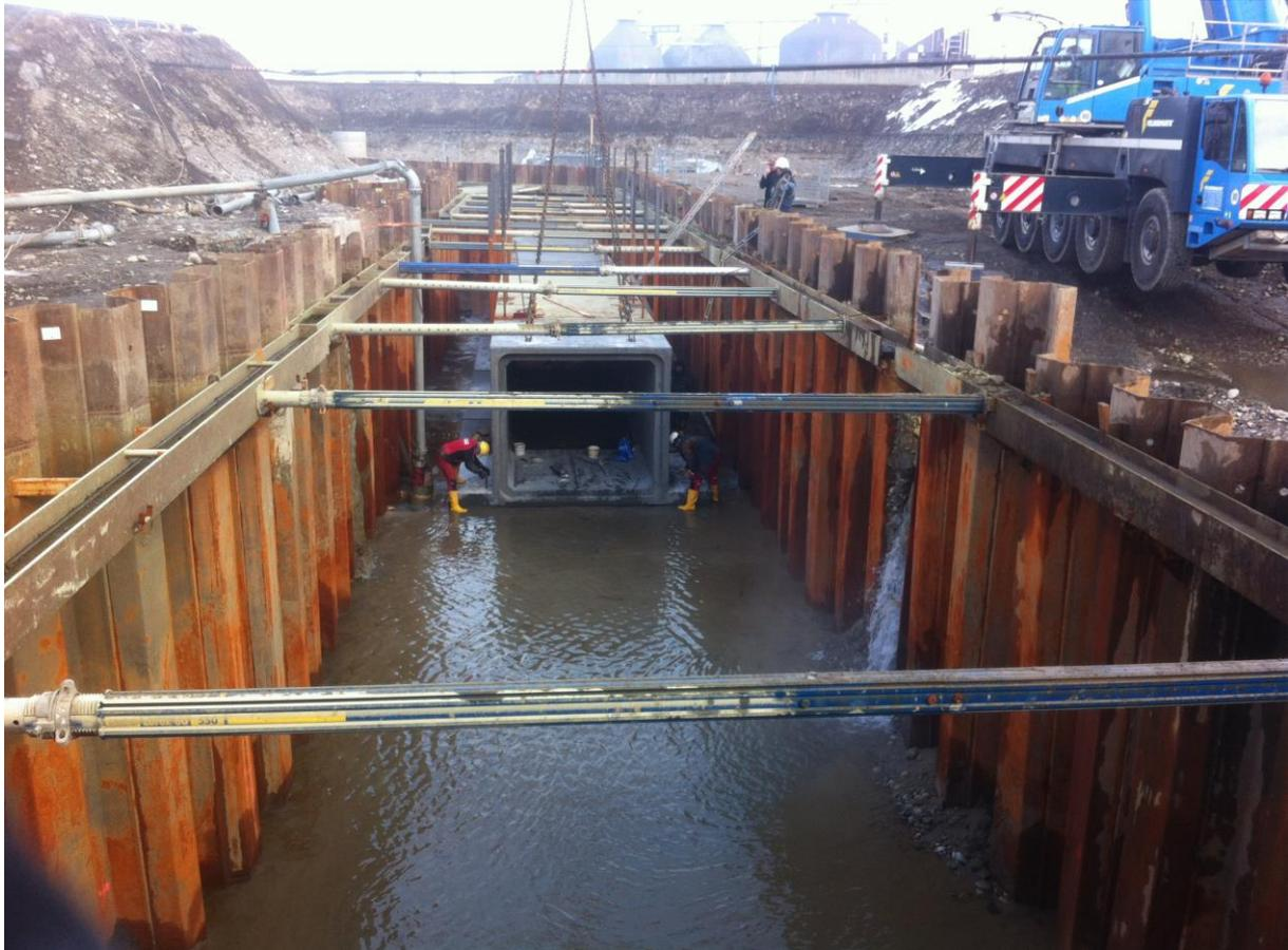
Abb. 5 Baugrube Gössendorf (08.01.2015)
