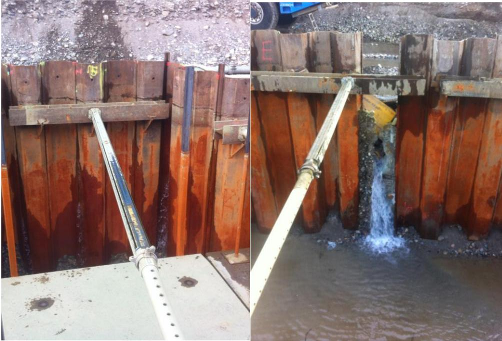
Abb. 8 Eindringen von Wasser in die Baugrube
