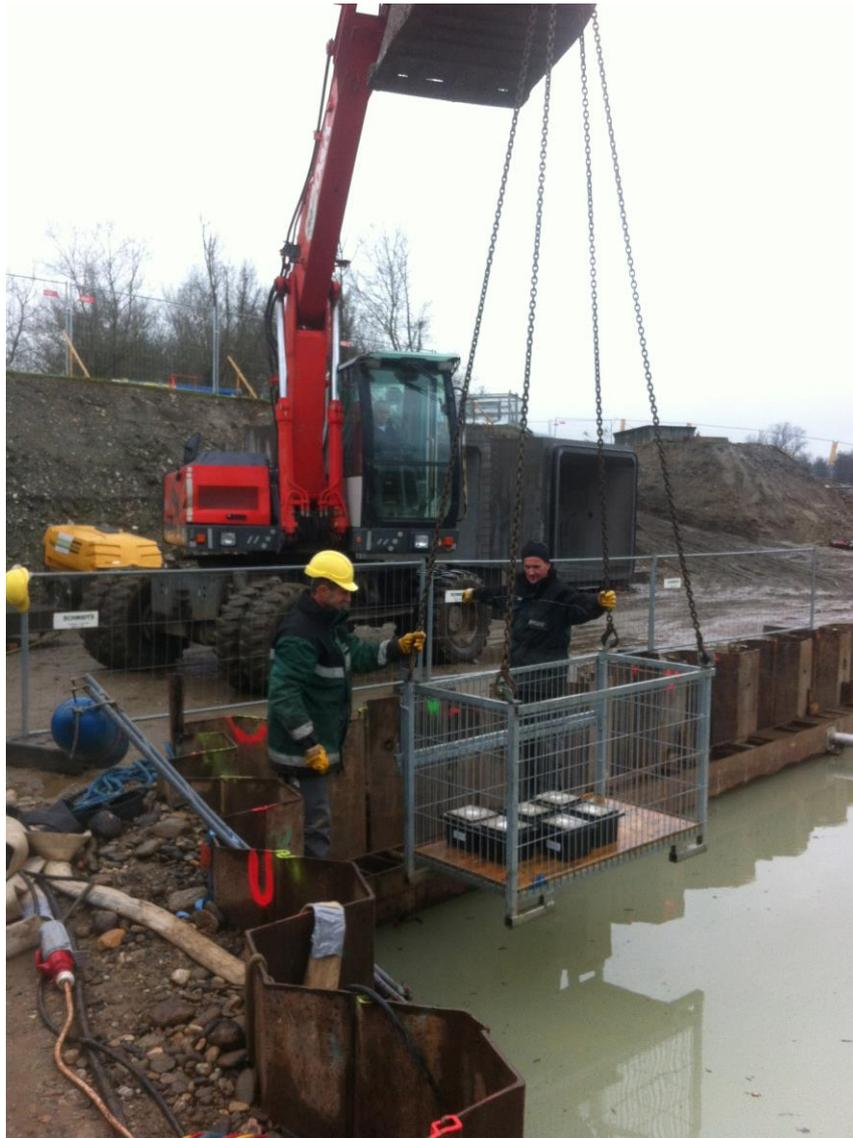
**Abb. 18** Einheben der Faserbetonwürfel
