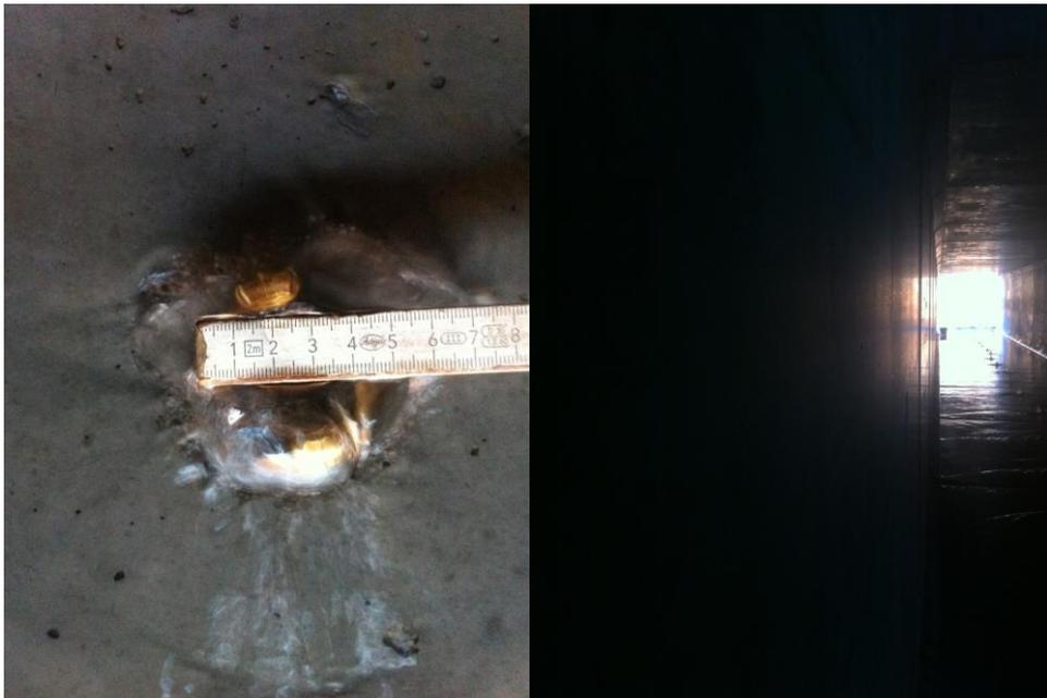
Abb. 70 GEKA Aufsatz Tiefbaumörtel Ventil
