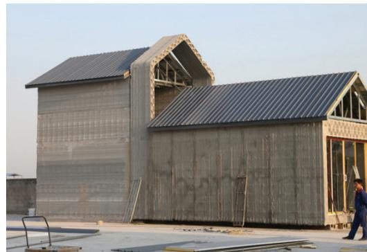
**Bild 75.** links, Abbildung der fertiggestellten Beton 3D Druckhäuser.
