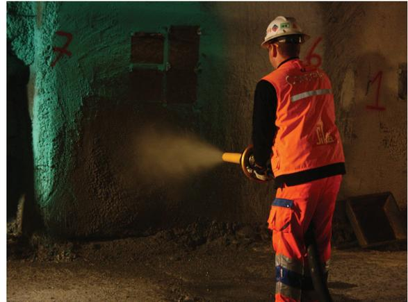
**Bild 4.** rechts, Spritzbetonversuche im Versuchsstollen Hagerbach (CH)
