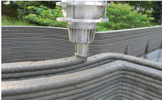
Bild 399. links, 3D Printed Concrete Castle
