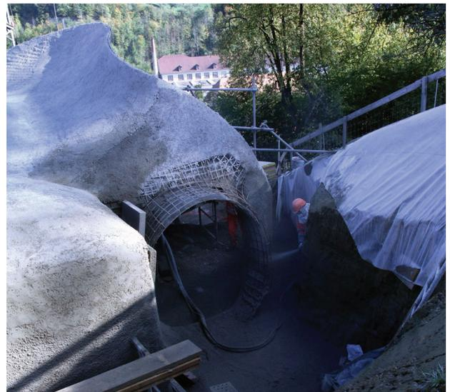
Das Spritzbetonverfahren ist komplett ohne Schalung möglich. Das Nassspritzverfahren erlaubt, wie auf der Abbildung 5. und 6. gezeigt, ein mehrlagiges Auftragen auf ein Maschengewebe. Dabei wird von unten nach oben, Schicht um Schicht der Beton aufgespritzt.<sup>8</sup>
