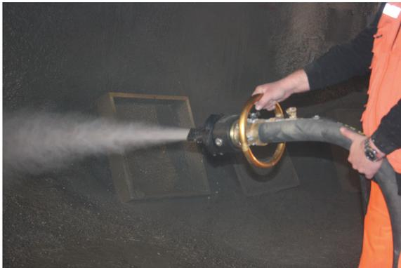
**Bild 114.** rechts, Der Beton verstopft die Düse. Eingearbeitete Windungen in der Düse haben keinen positiven Effekt.
