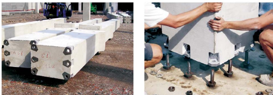
Abbildung 2-11: Stützenschuhe aus S355J2+N bei der Montage [26].
