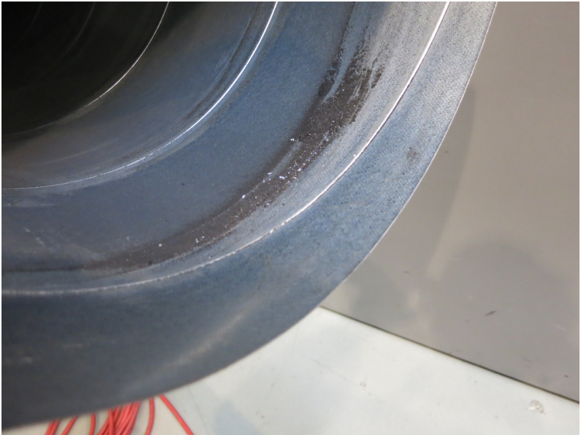
Abbildung 5-3 Verschmutzung am Rohrübergang
