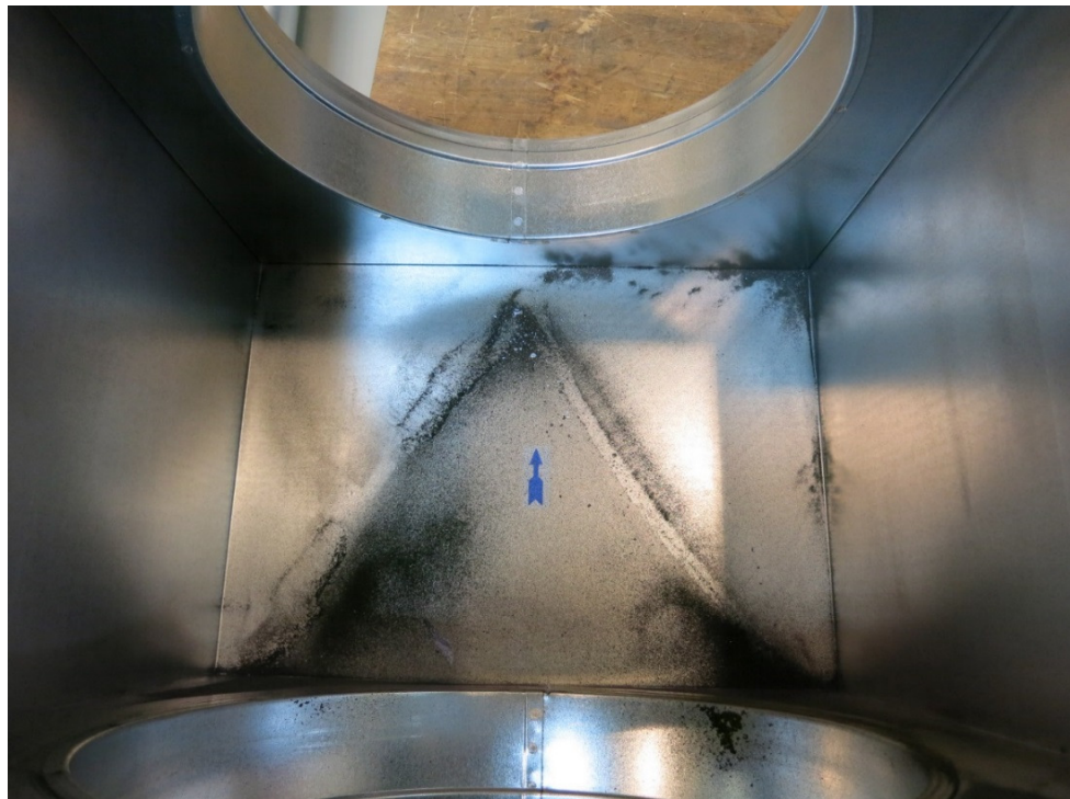
Abbildung 5-2 Verschmutzung der Luftfilterbox
