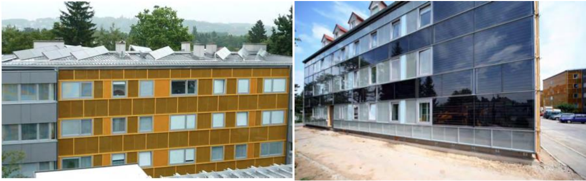
Abbildung 3-5: Dieselweg-Graz, Fassade mit integrierter Solarwabe und Solarkollektor [35]
