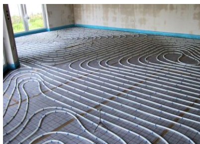
Abbildung 2-9: Großflächig verlegte Fußbodenheizung [26]
