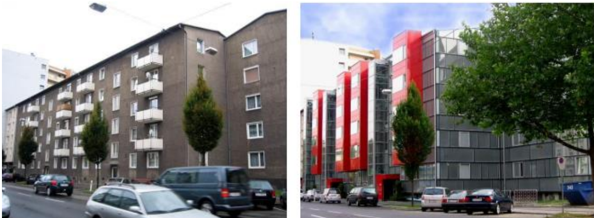
Abbildung 3-1: Makartstraße: Gebäudebestand (links); saniertes Gebäude (rechts) [32]
