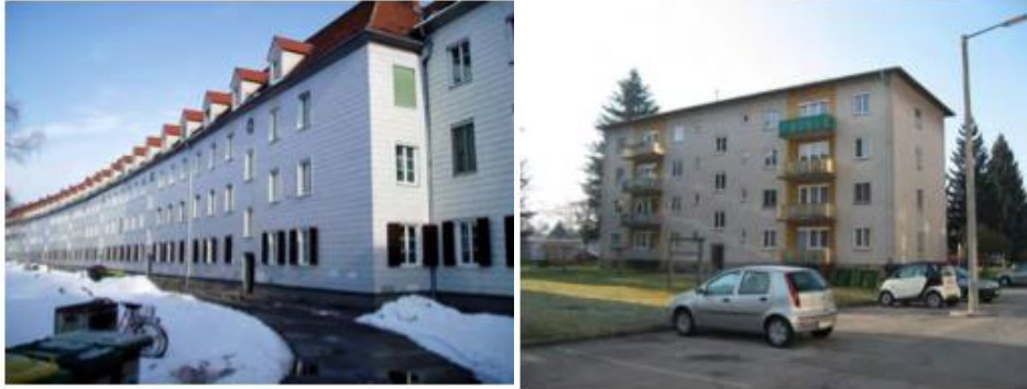
Abbildung 3-4: Dieselweg Graz-Liebenau Bestand [35]
