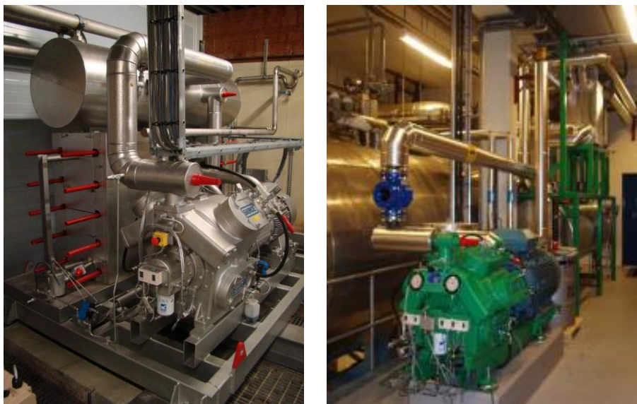
Abbildung 2-5: Bilder zweier „hybrider“ Wärmepumpen der Firma „Hybrid Energy AS“, links: 416 kW (Goget, 2013), rechts: 650 kW Heizleistung (Nordtvedt, 2009)
