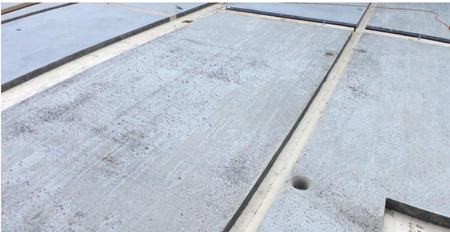
Bild 2.43 Versetzen der HBV-Fertigteile im 2.OG auf der Baustelle in der Paulasgasse, Wien – Schwechat
