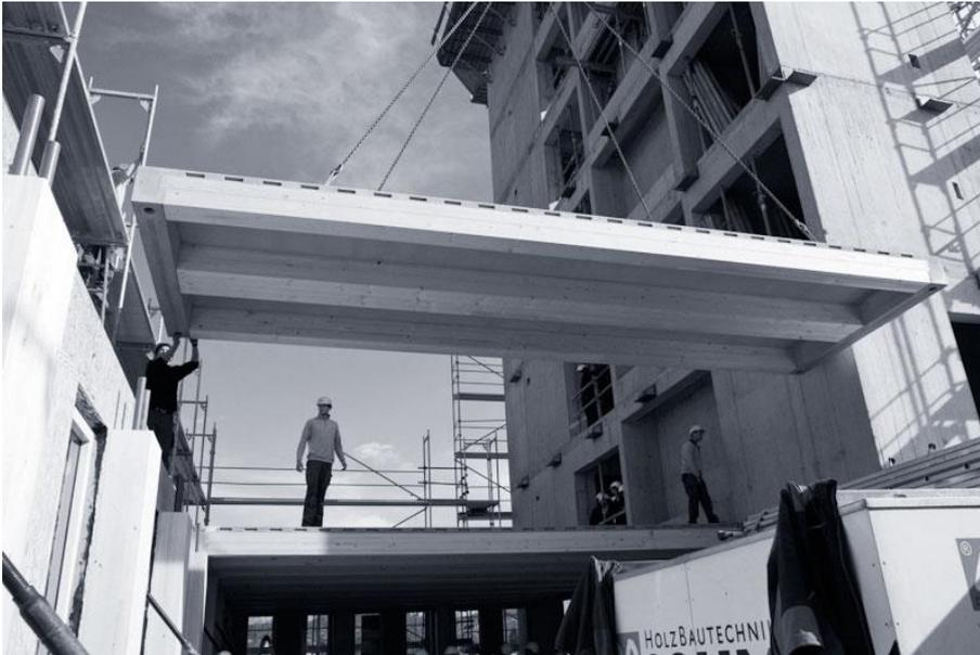
Bild 2.48 Versetzen eines HBV-Deckenelement am Life Cycle Tower<sup>169</sup>
