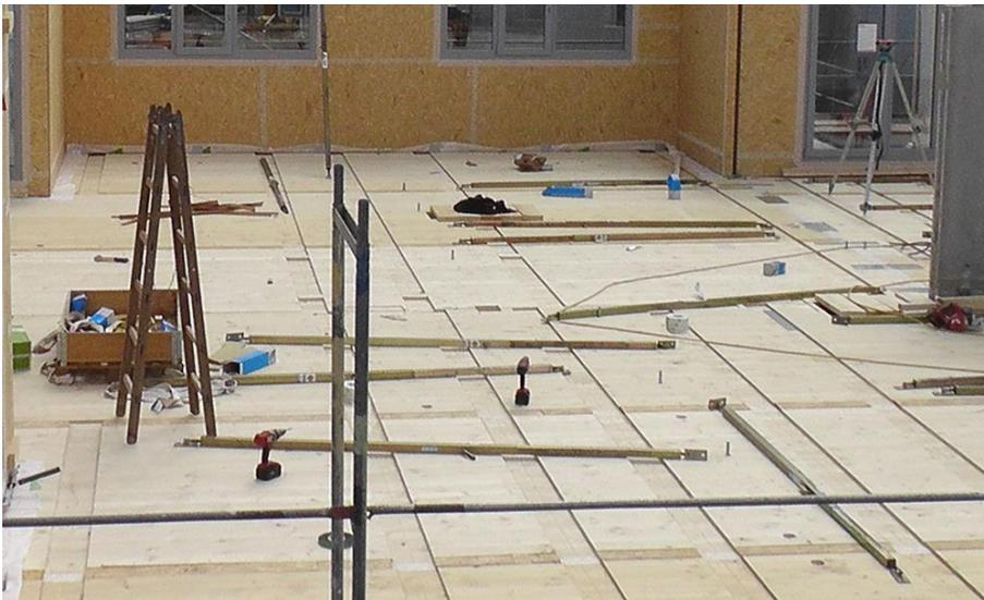
Bild 2.36 Versetzen der BSP-Fertigteile im 2.OG auf der Baustelle in der Paulasgasse, Wien – Schwechat
