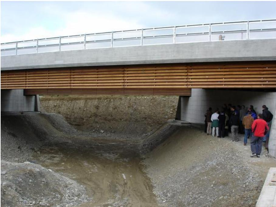
Bild 2.18 Verkehrsbrücke in Holz-Beton-Verbund-Bauweise, Schweiz<sup>103</sup>
