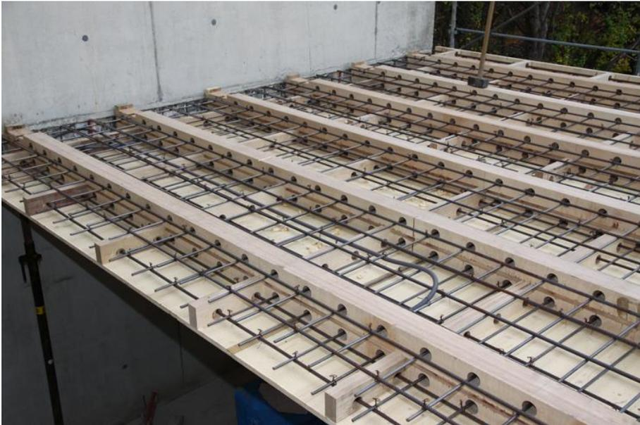
Bild 2.34 Betoniervorgang auf der Baustelle – Verbindungssystem im Werk vorgefertigt, Kreuzrippendecke X-Floor<sup>138</sup>
