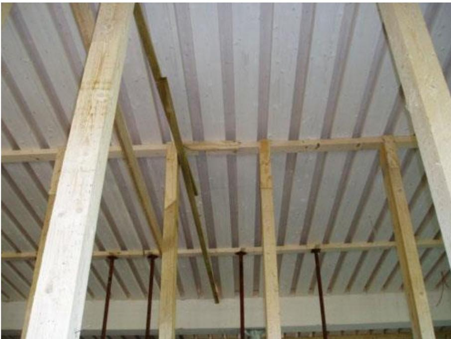
Bild 2.13 Betoniervorgang auf der Baustelle – HBV-Variodecke<sup>85</sup>
