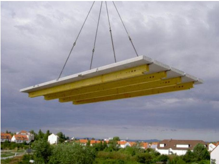
Bild 2.19 Ansicht einer HBV-Rippendecke<sup>106</sup>
