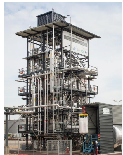
Abbildung 5.1: Die bioCRACK-Pilotanlage am Raffineriestandort Schwechat und die analysierten Parameter
