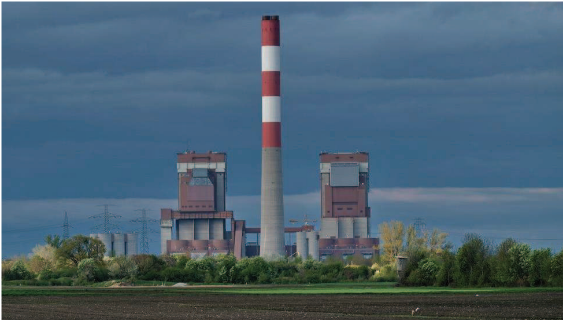
Fig. 5-1. Power plant Dürnrrohr.
