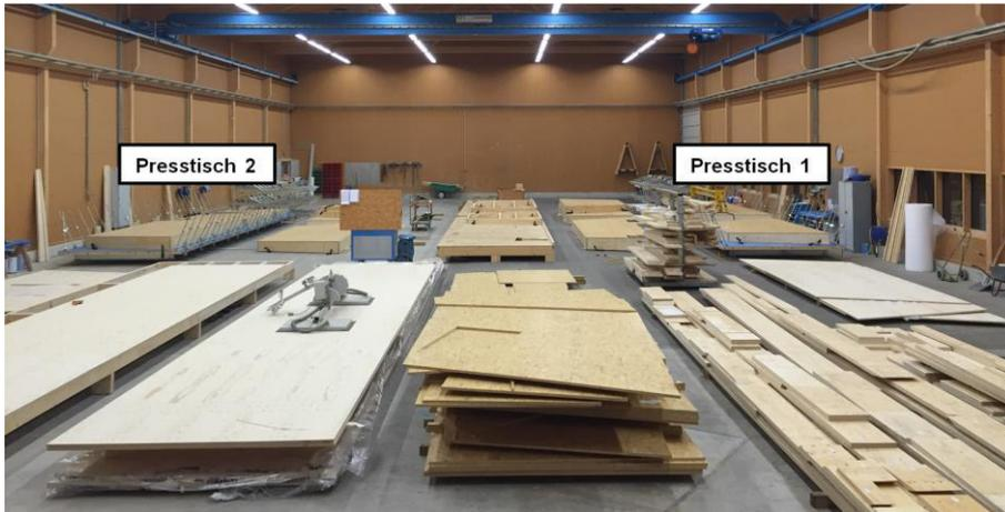
Abbildung 3.8: Vorfertigung von verklebten Hohlkasten-Dachelementen (Zimmerei Sieveke GmbH)
