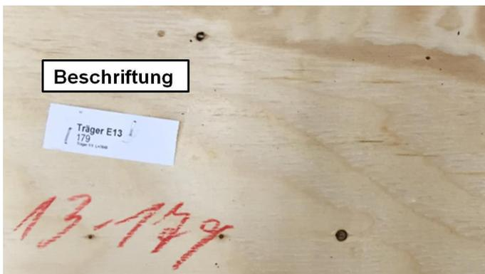
Abbildung 3.56: Bauteilbeschriftung (Projekt B)
