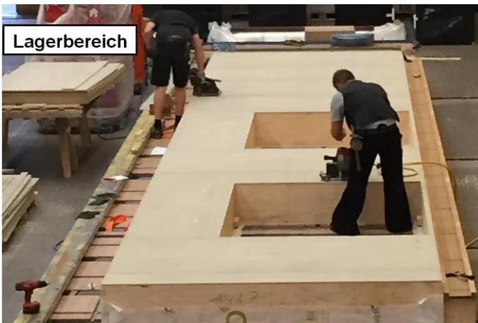
Abbildung 3.42: Montage der äußeren Beplankung (Projekt A)
