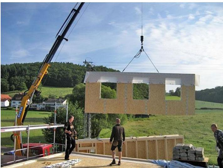
Abbildung 2.54: Montage eines Holzrahmenelementes auf der Baustelle<sup>313</sup>
