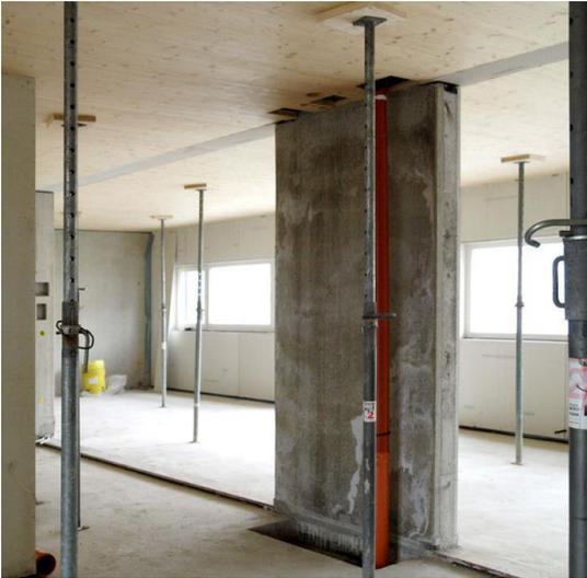
Abbildung 3.3: Hybridbauweise der Zimmerei Sieveke GmbH<sup>389</sup>
