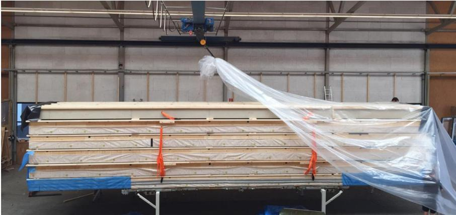
Abbildung 3.48: Einfolierung der Ladung (Projekt A)
