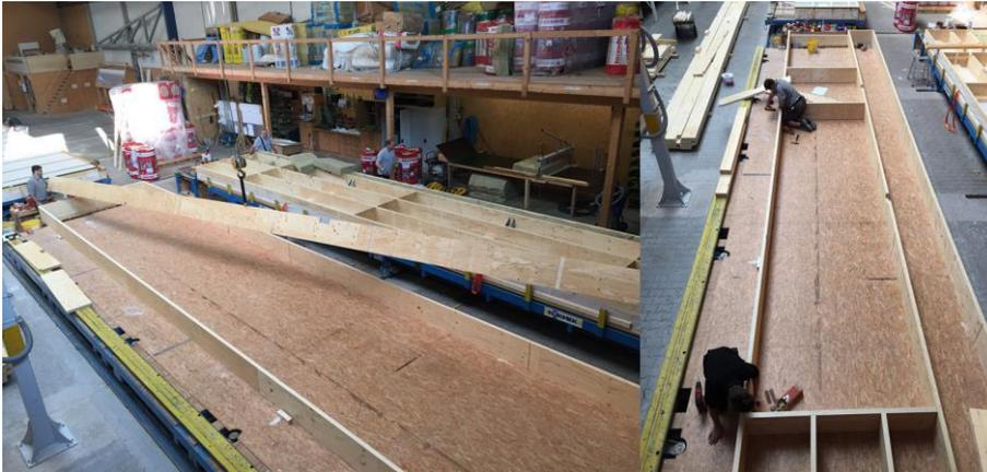
Abbildung 3.35: Zusammenbau Riegelwerk (Projekt A)
