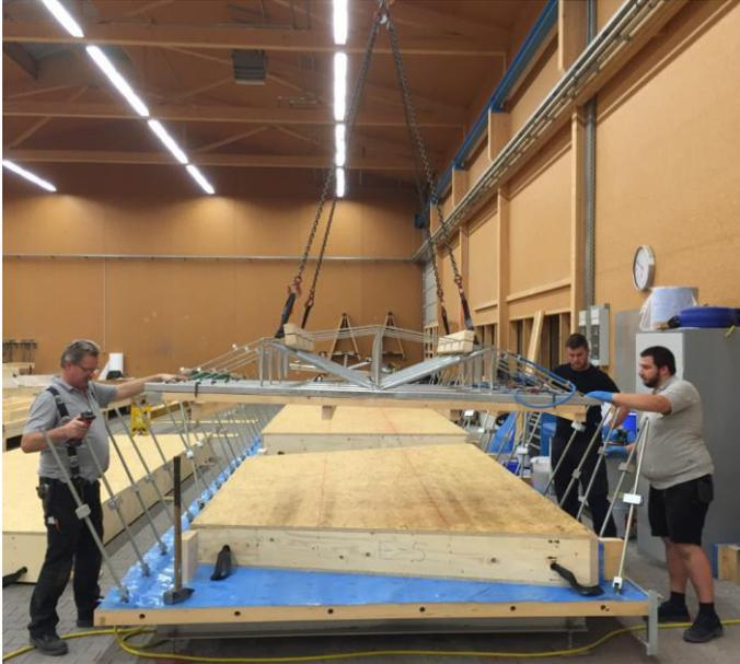
Abbildung 3.77: Anbringung der Pressgestelle (Projekt B)
