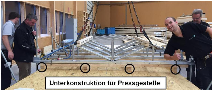
Abbildung 3.62: Unterkonstruktion für Pressgestelle (Projekt B)
