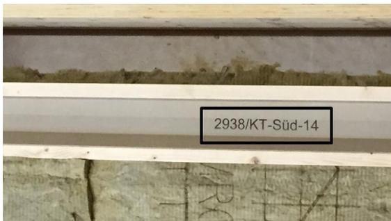
Abbildung 3.29: Bauteilbeschriftung (Projekt A)
