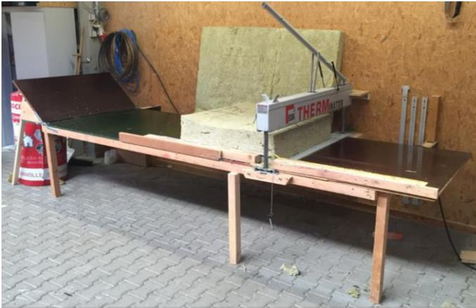
Abbildung 3.25: Zuschnitt der Dämmstoffbahnen (Projekt A)
