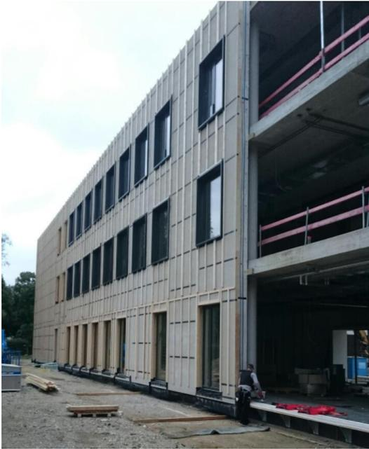
Abbildung 3.12: vertikaler Einbau der Elemente auf der Baustelle (Projekt A)<sup>401</sup>
