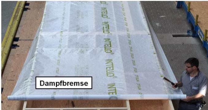
Abbildung 3.37: Befestigung der Dampfbremse (Projekt A)
