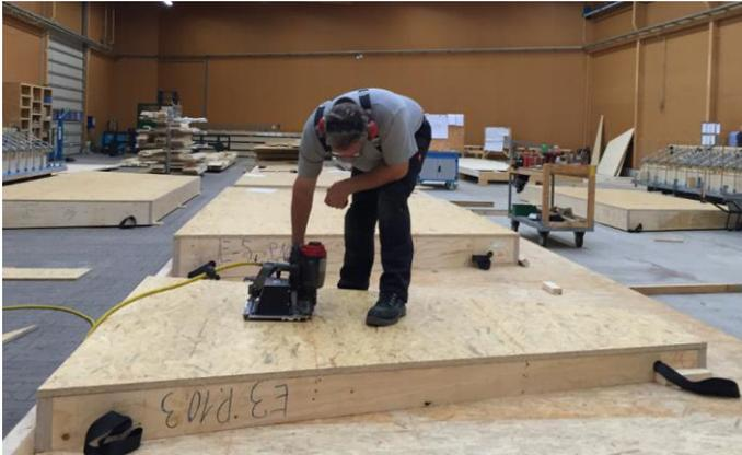
Abbildung 3.72: Montage der oberen Beplankung (Projekt B)
