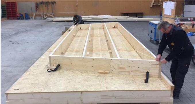
Abbildung 3.70: Ausrichtung des Elements (Projekt B)
