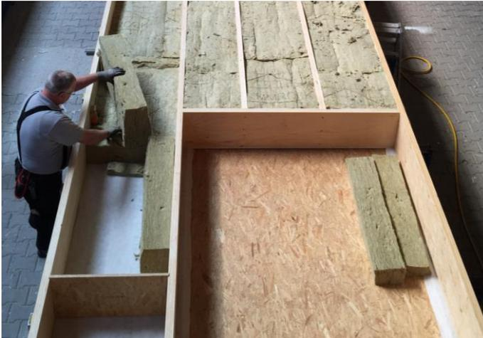
Abbildung 3.40: Einbau der Dämmung (Projekt A)
