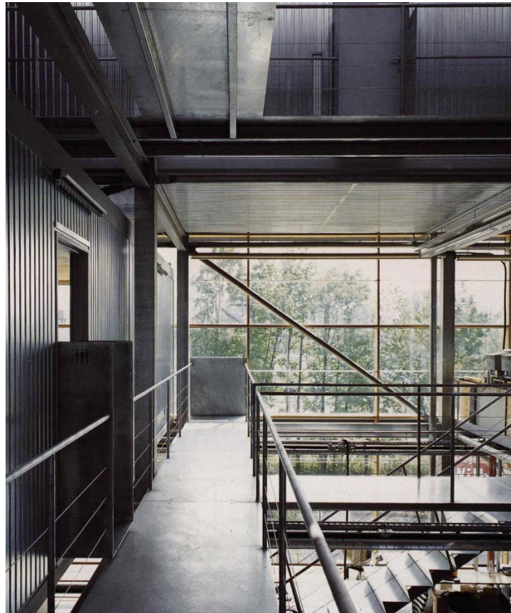
Abb. 57: Innenraum Bürogebäude Fellbach
