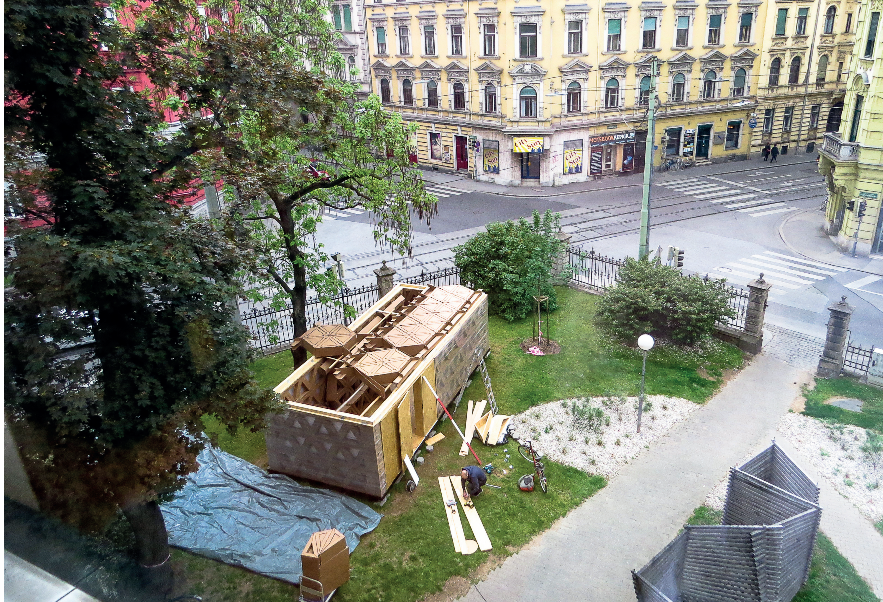
Abb. 95 Alle Wandelemente sind vollständig montiert und eingestretched. Das Türelement ist eingesetzt. Die Dachmodule werden liegend vormontiert um anschließend aufgerichtet zu werden.
