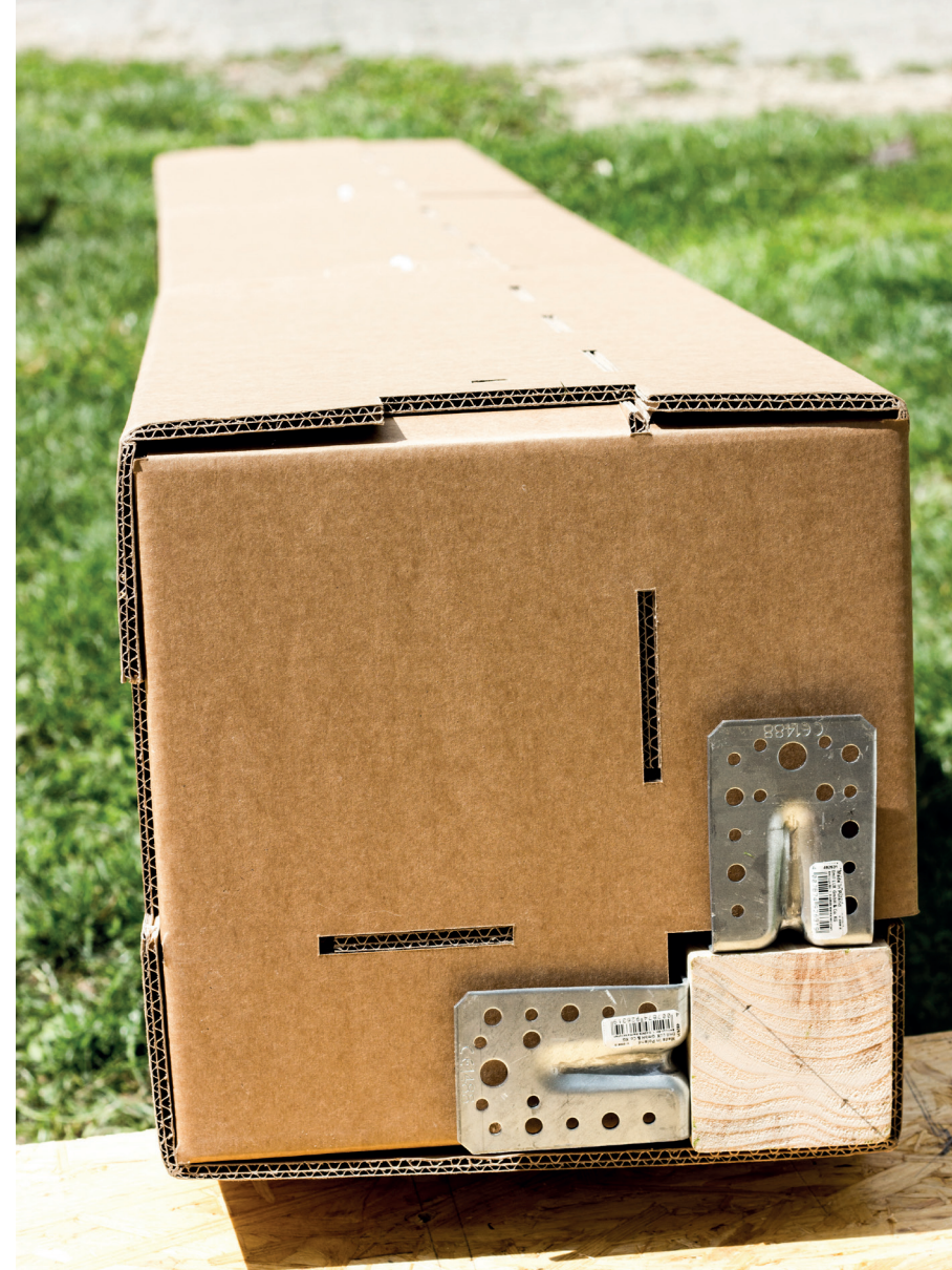
Abb. 85 Untersicht des Eckmoduls mit eingesetzter Stütze und Winkeln
