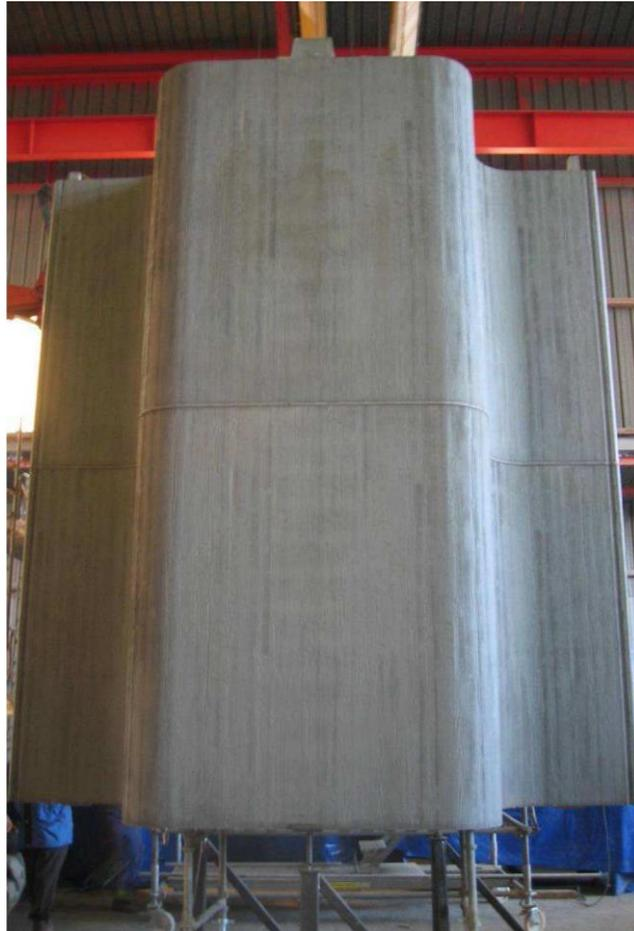
Abbildung 25: Match-Cast-Verfahren (vertikal) [24]
