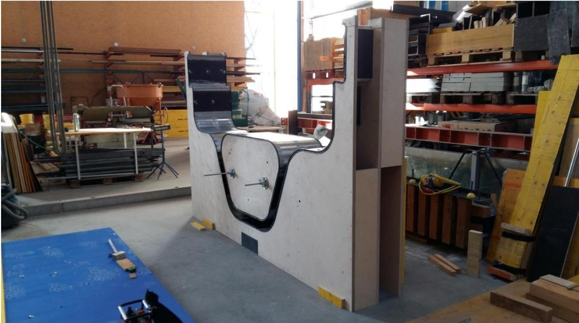
Abbildung 57: Innenschalung mittels Ankerstäben an Stirnschalung befestigt.
