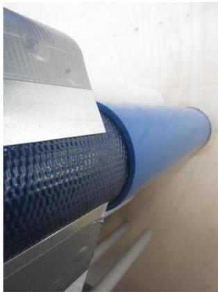
Bereich Blech, Abdeckplatte, Hüllrohr mit aufgeblasenen Schlauch
