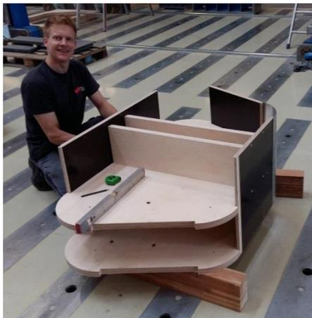
Abbildung 47: Querschott (Innenschalung)
