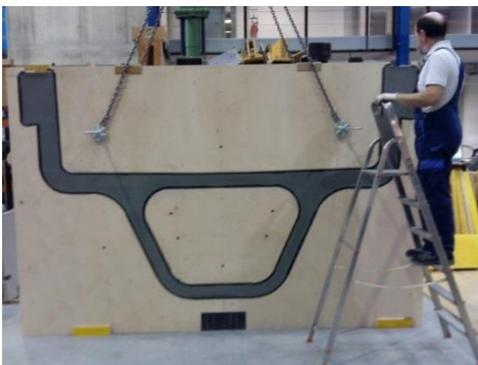
Abbildung 67: Anheben der Konterschabung
