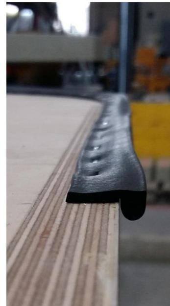
Abbildung 43: Abdichtung Kederprofil
