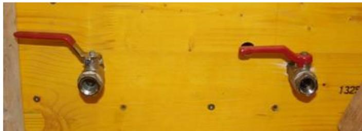
Abbildung 83: Ventile zum Luft ablassen
