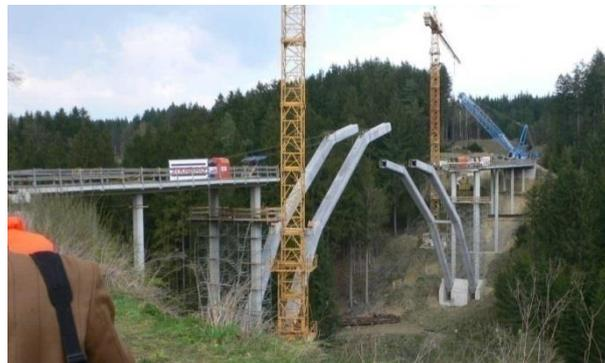
Abbildung 29: Einklappen der zwei Bogenhälften [24]
