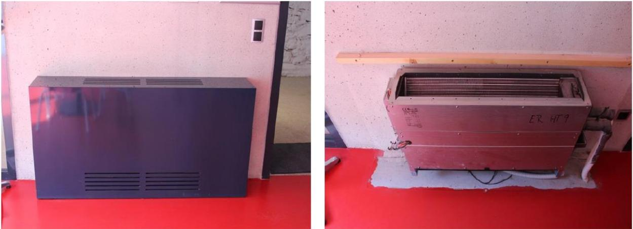
Abbildung 4-3: Innengerät mit Abdeckung (links) und ein Innengerät ohne Abdeckungen (rechts)
