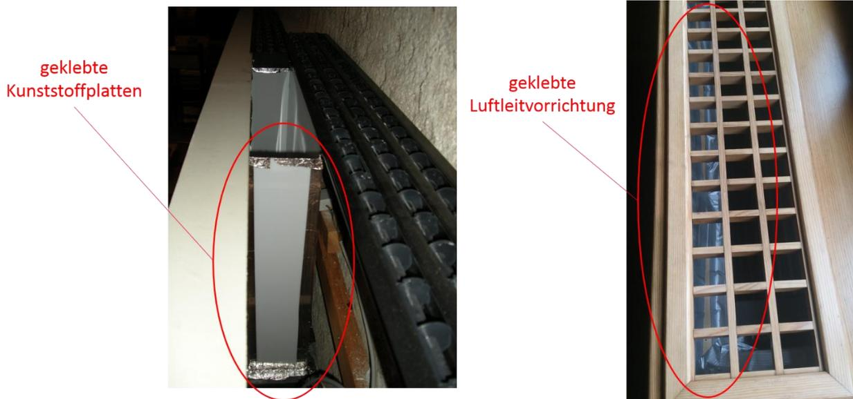
Abbildung 4-7: Luftleitvorrichtung für AG8 im Gewölbe (links) und AG3 im Rittersaal (rechts)
