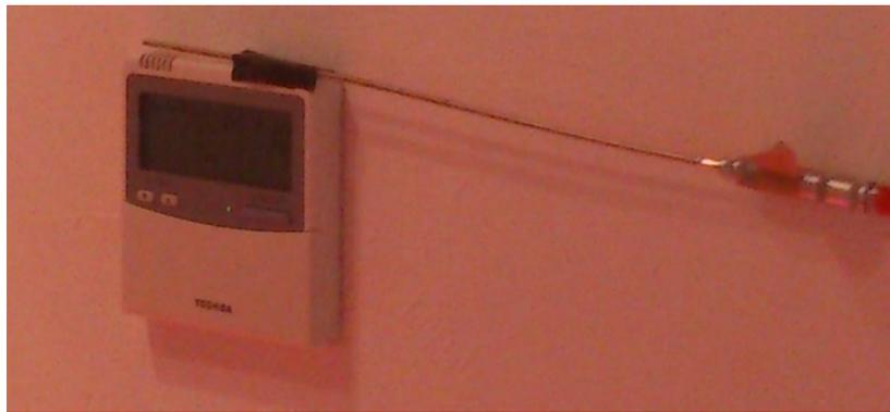
Abbildung 4-21: Temperatursensor troom,regulation an der Fernbedienung der Toshiba Wärmepumpe
