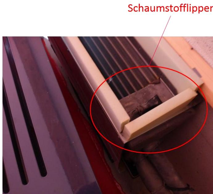
Abbildung 4-6: Luftleitvorrichtung durch Schaumstofflippen für AG8 in der Ritinger Bar
