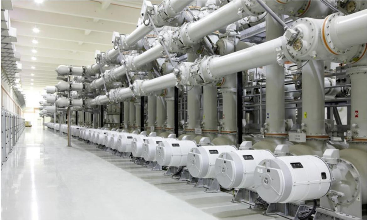
Abbildung 3.3: Gekapselte SF<sub>6</sub>-Anlage [14]
