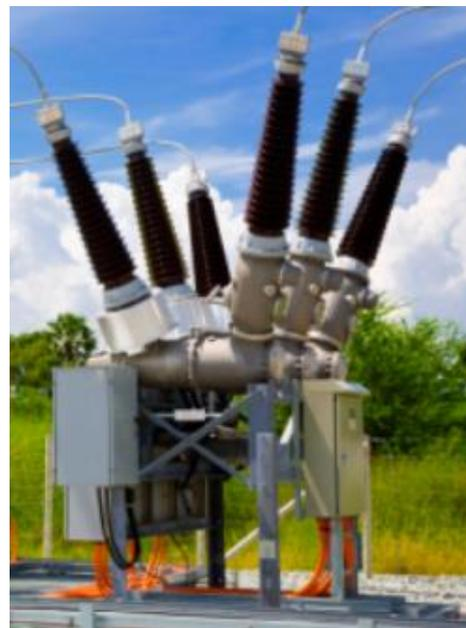
Abbildung 3.5: Freiluft Leistungsschalter (l) [6] – SF<sub>6</sub>-Leistungsschalter (r) [17]
