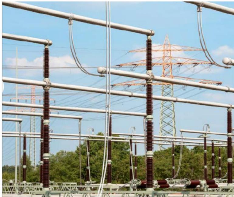
Abbildung 3.4: Abbildung von Sammelschienen [6]
