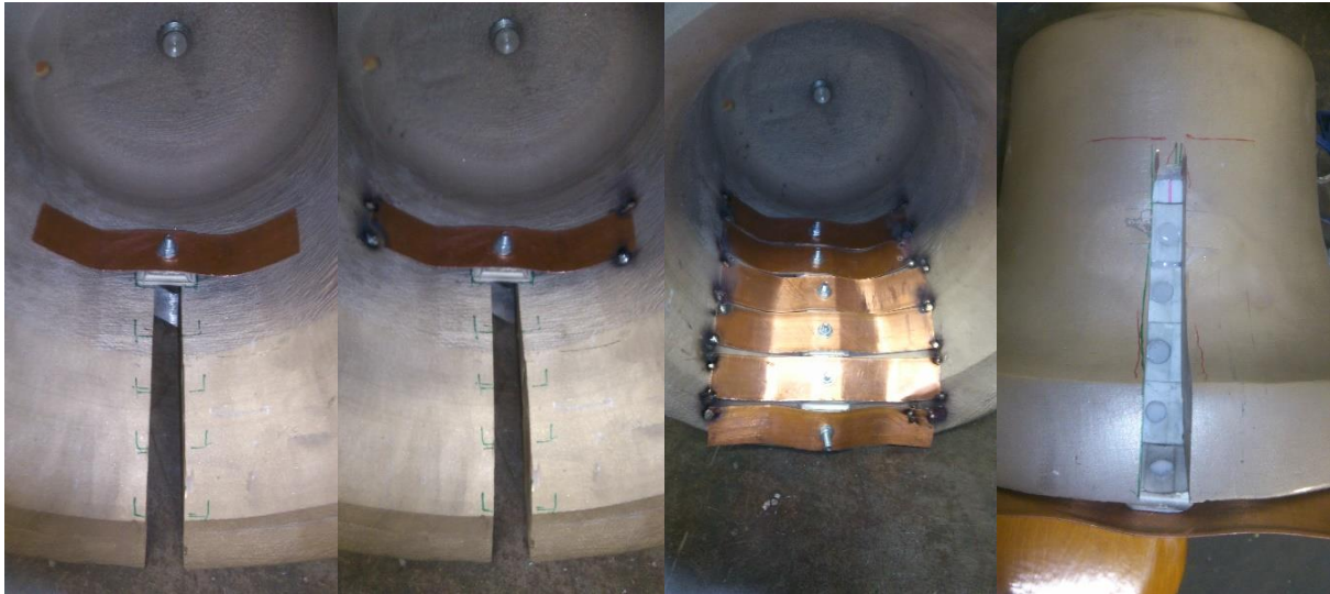
Abbildung 41: Schmelzbadsicherung aus finalem Schweißversuch, Bilder von links nach rechts: 1. Positionierung der Keramik-Kupferverbindung an der Glockeninnenseite, 2. Anheften der Kupferplatte an der Glockeninnenseite mittels MAG-Schweißverfahren, 3. Reihe an angehefteten Kupferplatten, 4. Keramikplatten mit Flüssiggas-gefüllten Bohrlochsenkungen
