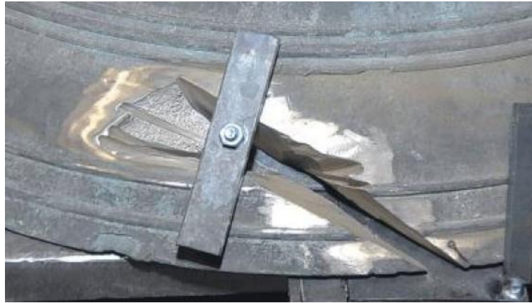
Abbildung 3: Hilfskonstruktion zur Glockenreparaturschweißung [8]
