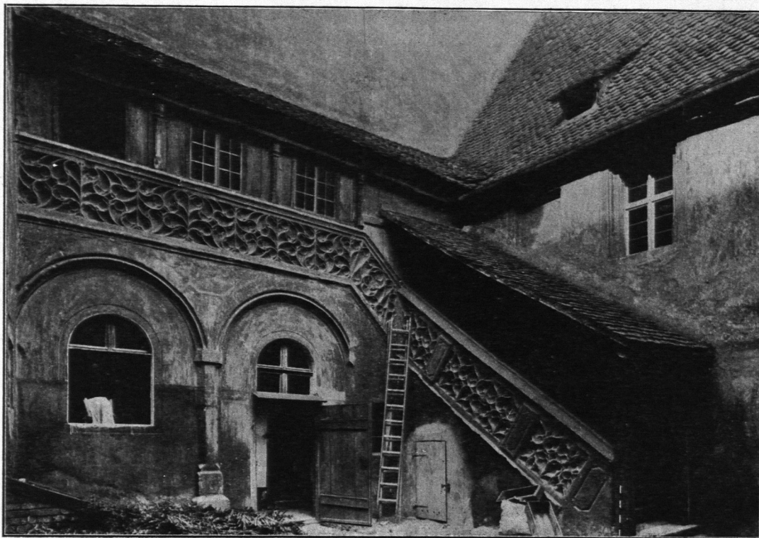
Abb. 173. Rathaus zu Amberg. Treppenaufgang im Hof.
