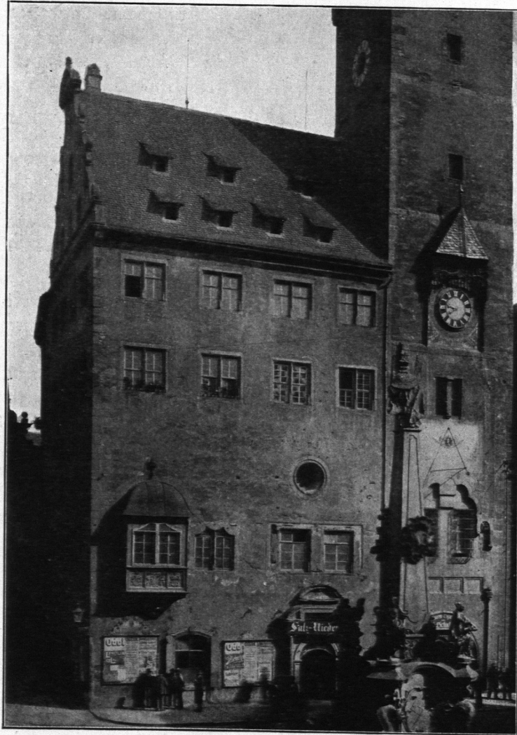
Abb. 165. Rathaus zu Würzburg. Unterer Teil der Marktseite.
