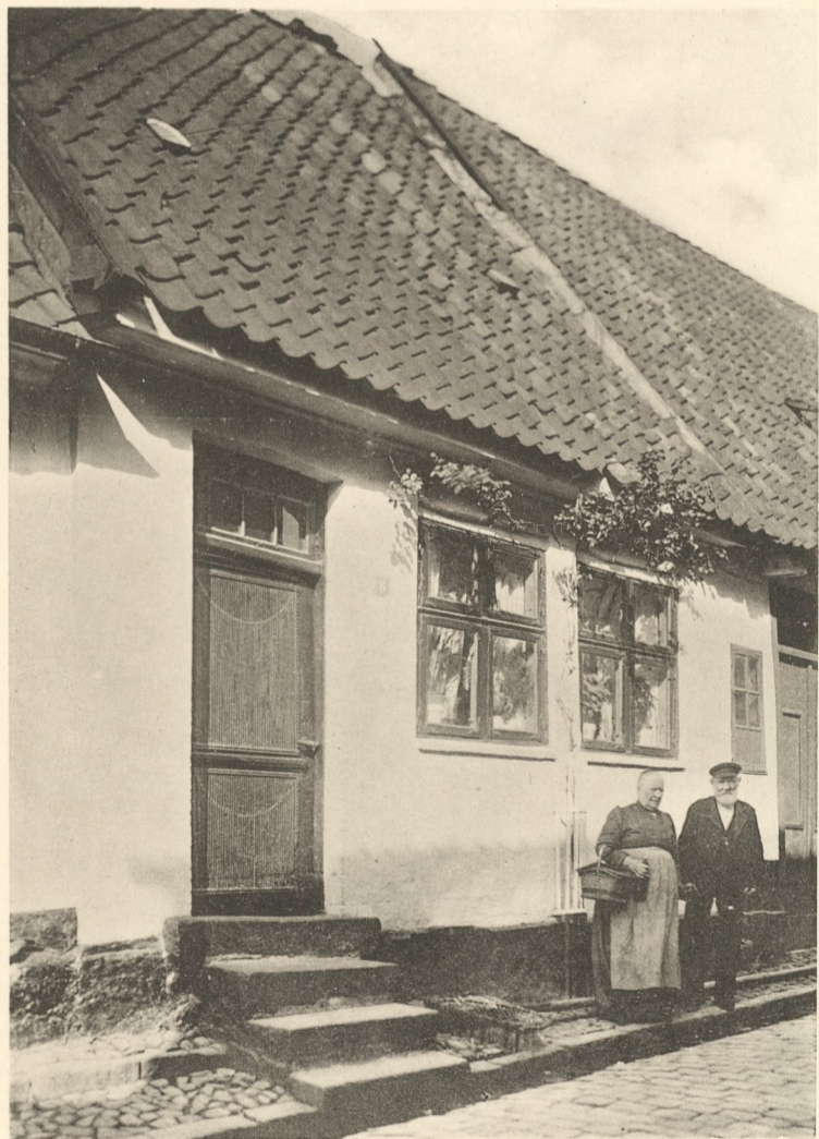
Schleswig, Fischerhaus Fischbrücke 6.
