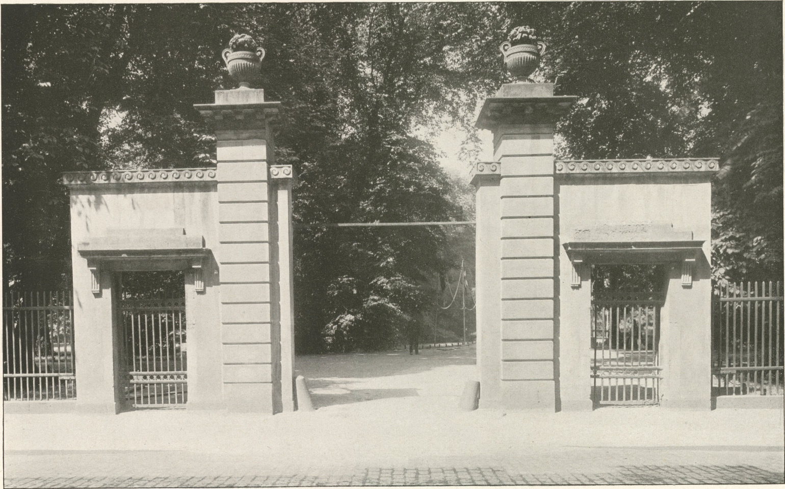
Portal des Rosenborgparks an der Kronprinsessegade in Kopenhagen.
