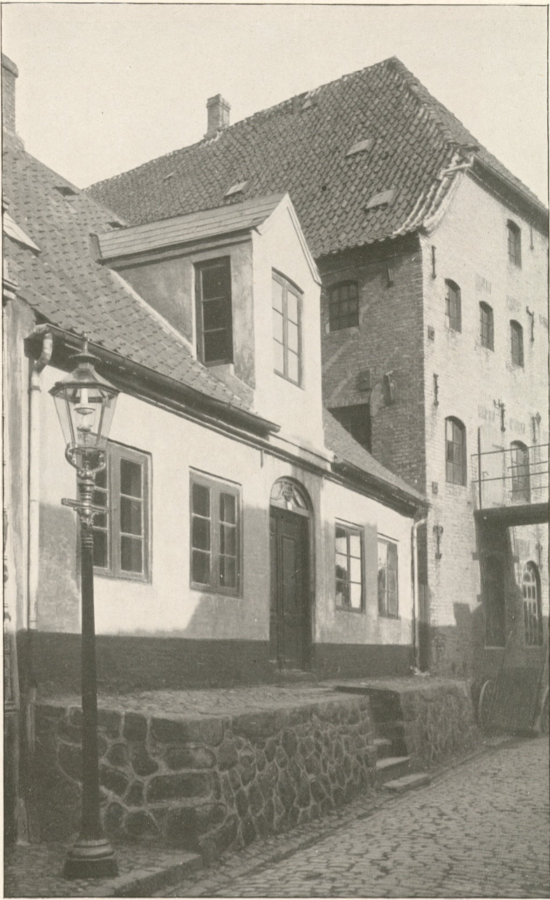
Haus Johannisstraße 80 in Flensburg.
