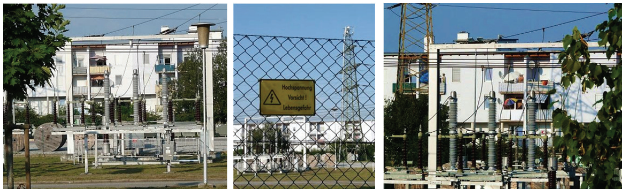
Abbildung 18 Umweltgerechtigkeit Kommunaler Wohnbau Neuholdaugasse, Graz, 1995, hinter dem Umspannwerk Süd
