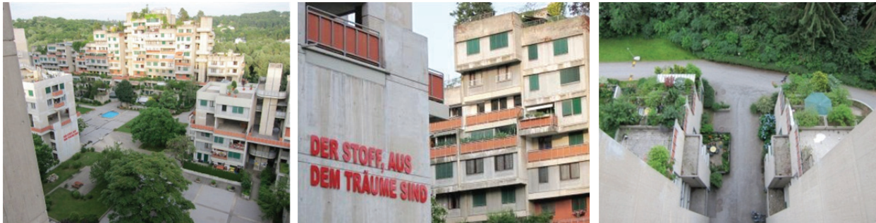
Abbildung 42: „Der Stoff, aus dem Träume sind“, Demonstrativbauvorhaben Terrassenhaussiedlung, Graz, 1972 bis 1978 nach Plänen von Eugen Gross, Friedrich Gross-Ransbach, Hermann Pichler, Werner Hollomey, Walter Laggner und Peter Trummer, Erscheinungsbild 2012
