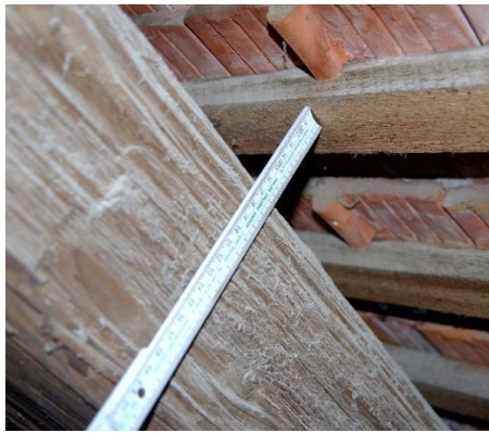
Abbildung 4-29: links: Durchbiegung Sparren 3.2, rechts: Durchbiegung Mitte VG 2
