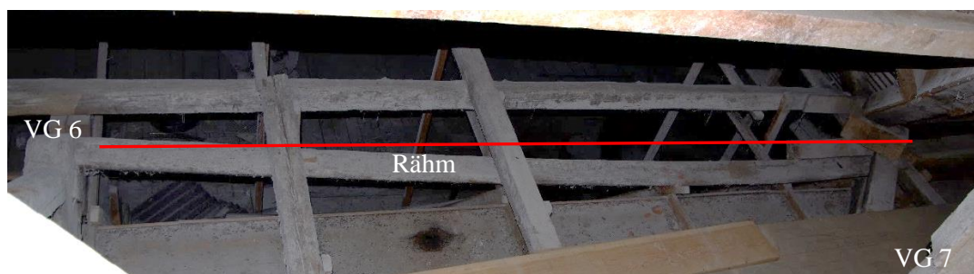
Abbildung 4-84: Verformung Rähm
