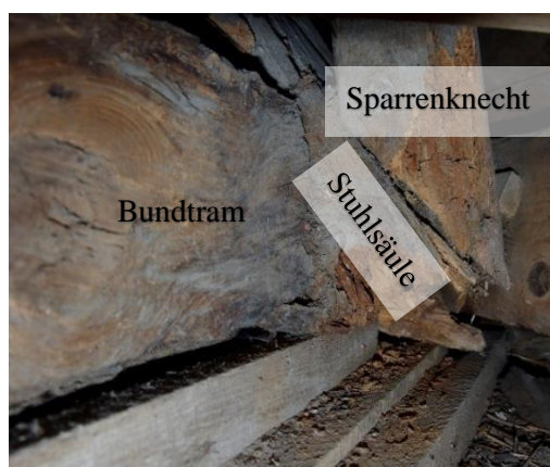
Abbildung 4-70: Fußpunkt Ichse (links: I.1, rechts: VG C)
