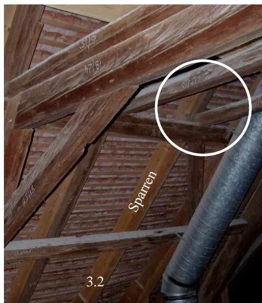
Abbildung 4-89: Bauteilfügung Sparren LG 3.2
