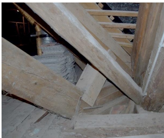
Abbildung 4-70: Fußpunkt Ichse (links: I.1, rechts: VG C)
