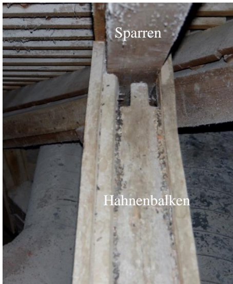
Abbildung 4-90: Instandsetzung Hahnenbalken 5.4 (Ansicht: von oben)
