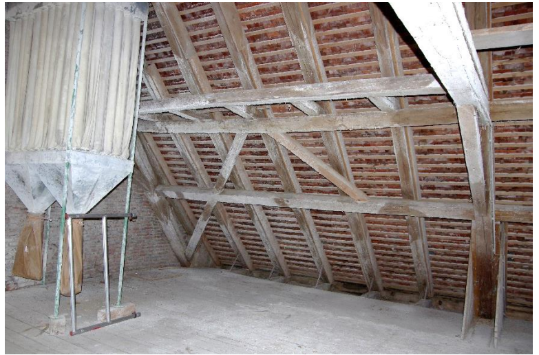
Abbildung 4-93: Instandsetzungen Fußpunkte
