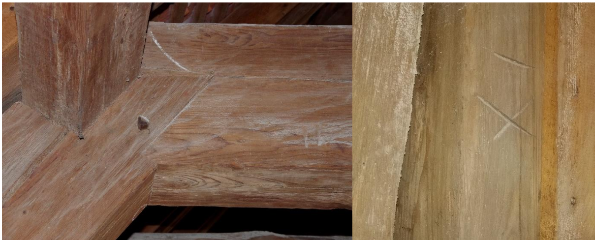
Abbildung 4-13: Abbundzeichen: links: Spannriegel, rechts: Sparren
