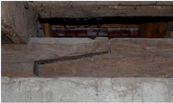
Abbildung 4-41: D01 Mauerbank (links: Ansicht, rechts: Detailausbildung)
