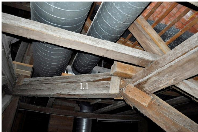
Abbildung 4-100: Ichsengespärre I.1, oben links: Fußpunkt, oben rechts: Anschluss VG 6 unten links: Ebene 2 (hinten), unten rechts: Ebene 2 (vorne)
