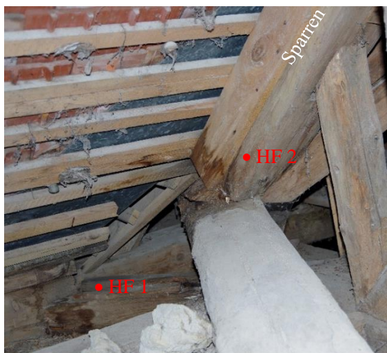
Abbildung 4-74: Fäulnisschäden I.2, VG C, VG 8
