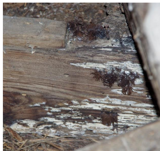
Abbildung 4-75: Pilzbefall am Bundtram
