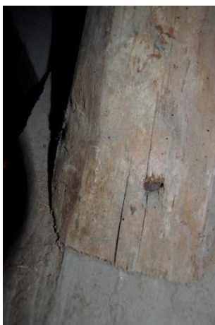
Abbildung 4-11: Verbindungsmittel aus Schmiedeeisen (links: Nagel, rechts: Bolzen)
