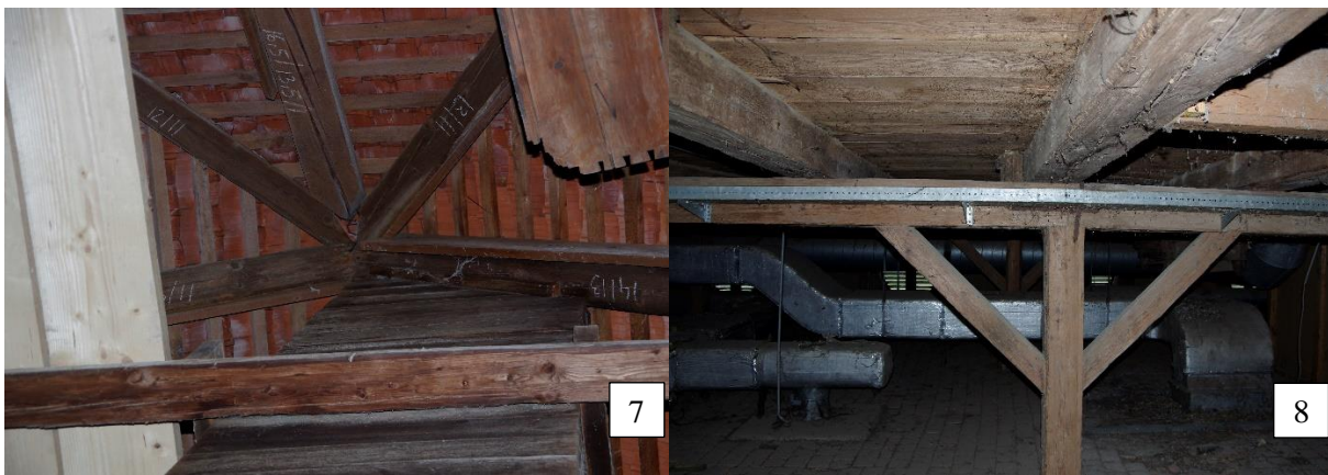
Abbildung 4-31: weitere fotografische Eindrücke des Dachstuhls
