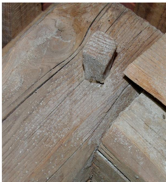
Abbildung 4-39: links: eingebauter Holznagel, rechts: Makroskopische Aufnahme Holznagel
