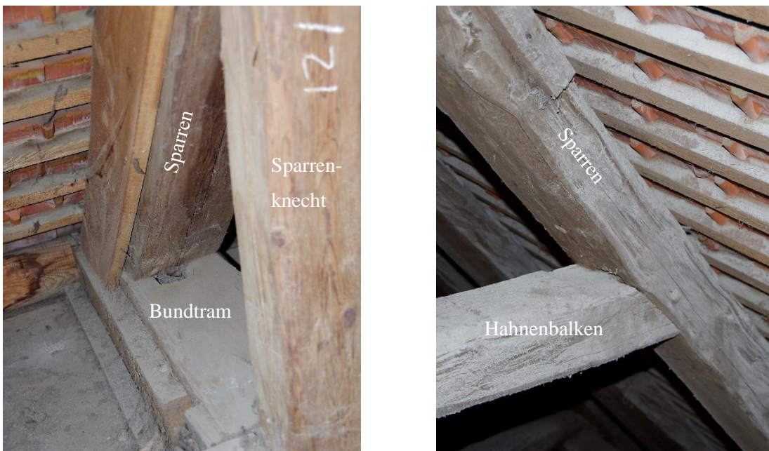
Abbildung 4-103: Beispiele für Klaffungen in Verbindungen links: Sparren-Bundtram, rechts: Hahnenbalken - Sparren
