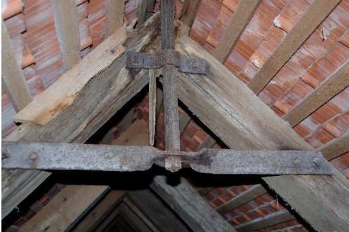
Abbildung 4-85: First LG 3.2 mit Blitzableiter
