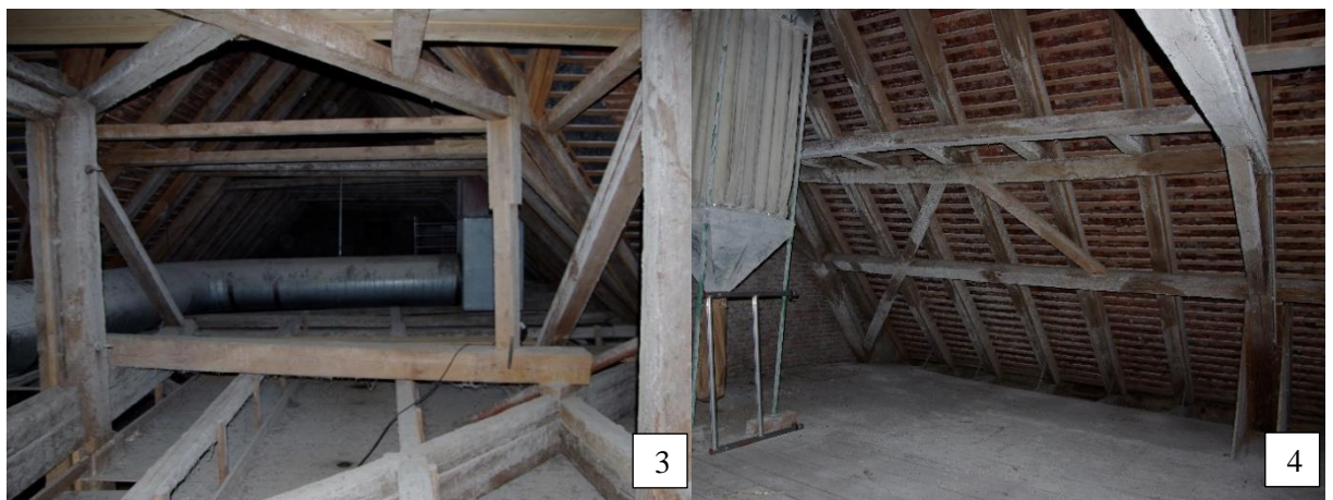
Abbildung 4-30: fotografische Eindrücke des Dachstuhls
