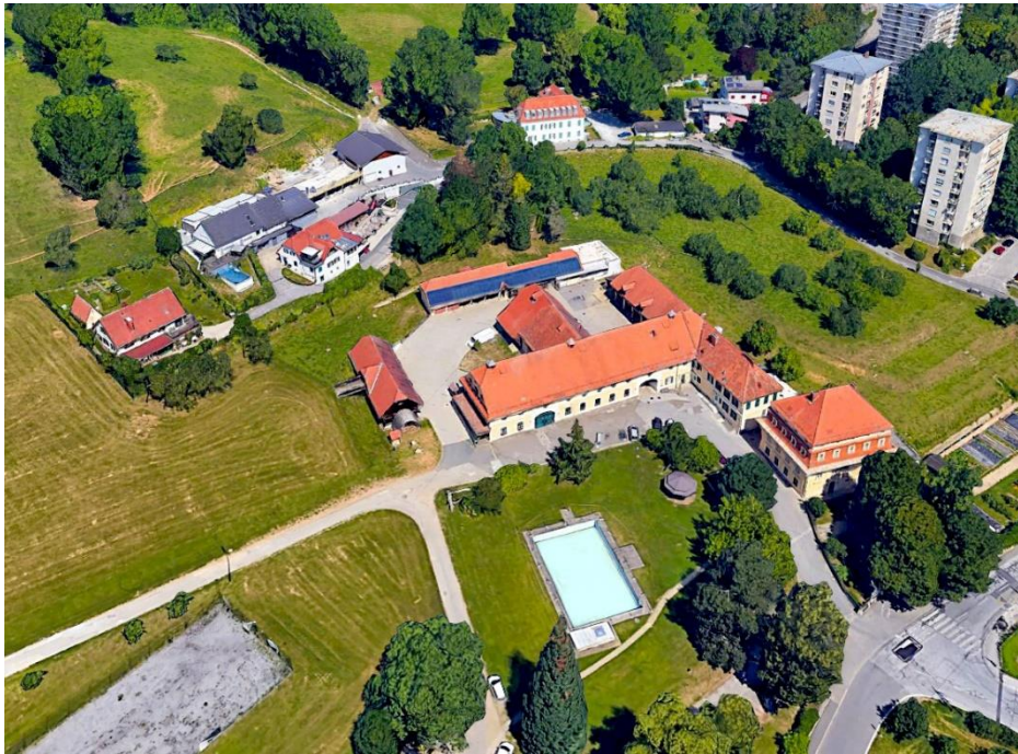
Abbildung 1-2: Wirtschaftsgebäude der LFS Grottenhof [Google Earth]
