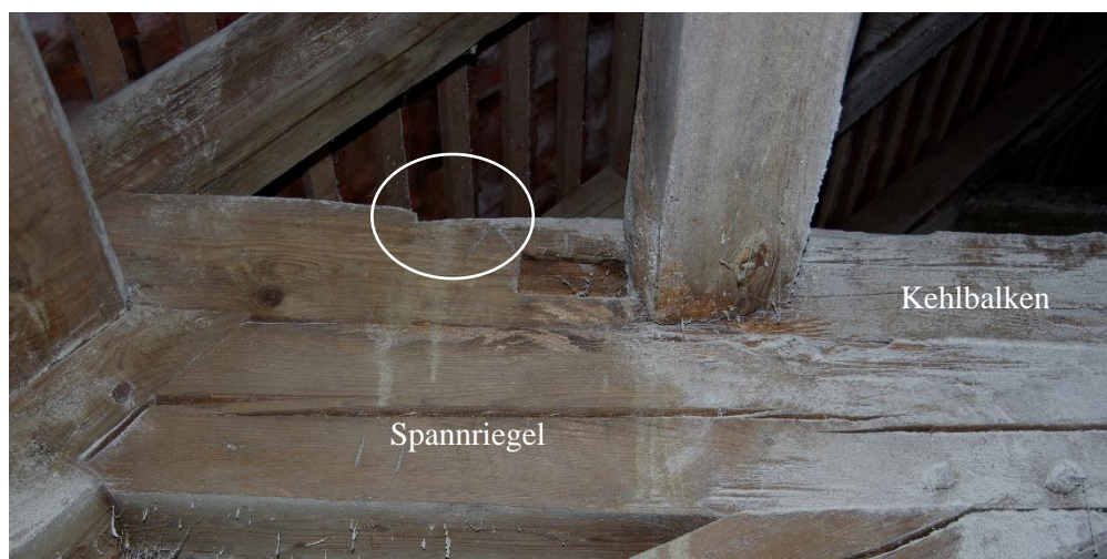
Abbildung 4-95: ersatzlos entfernte Strebe einer Hängesäule?
