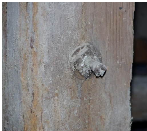
Abbildung 4-11: Verbindungsmittel aus Schmiedeeisen (links: Nagel, rechts: Bolzen)
