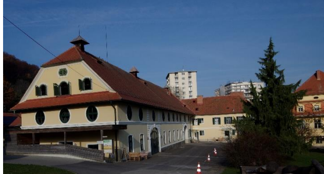
Abbildung 4-7: Ansicht Nordosten, rechts im Bild Nr. 104
