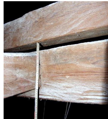
Abbildung 4-29: links: Durchbiegung Sparren 3.2, rechts: Durchbiegung Mitte VG 2
