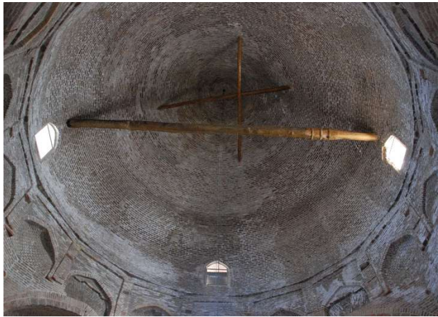
Abbildung 72: Unteransicht Innenkuppel, Salzausblühungen im unteren Bereich (L. Korn)
