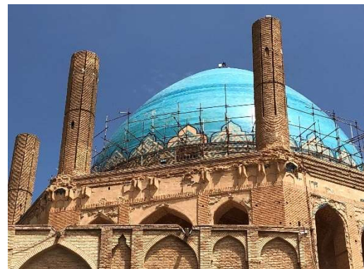
Abbildung 71: Außenkuppel des Öldscheitü-Mausoleums, Zustand 2019 (P. Schalk)
