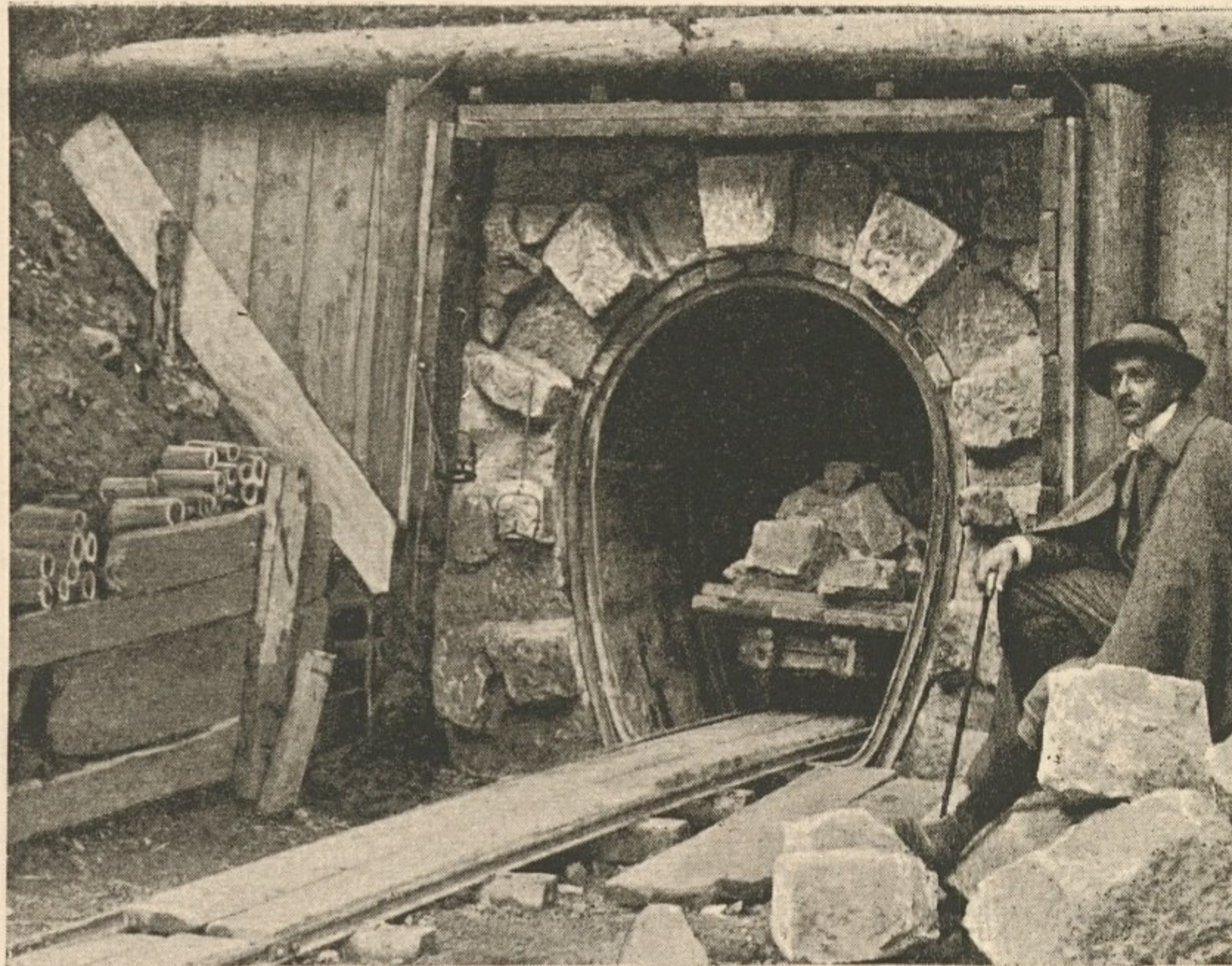
Nr. 69. Stolleneinwölbung im Bau.
