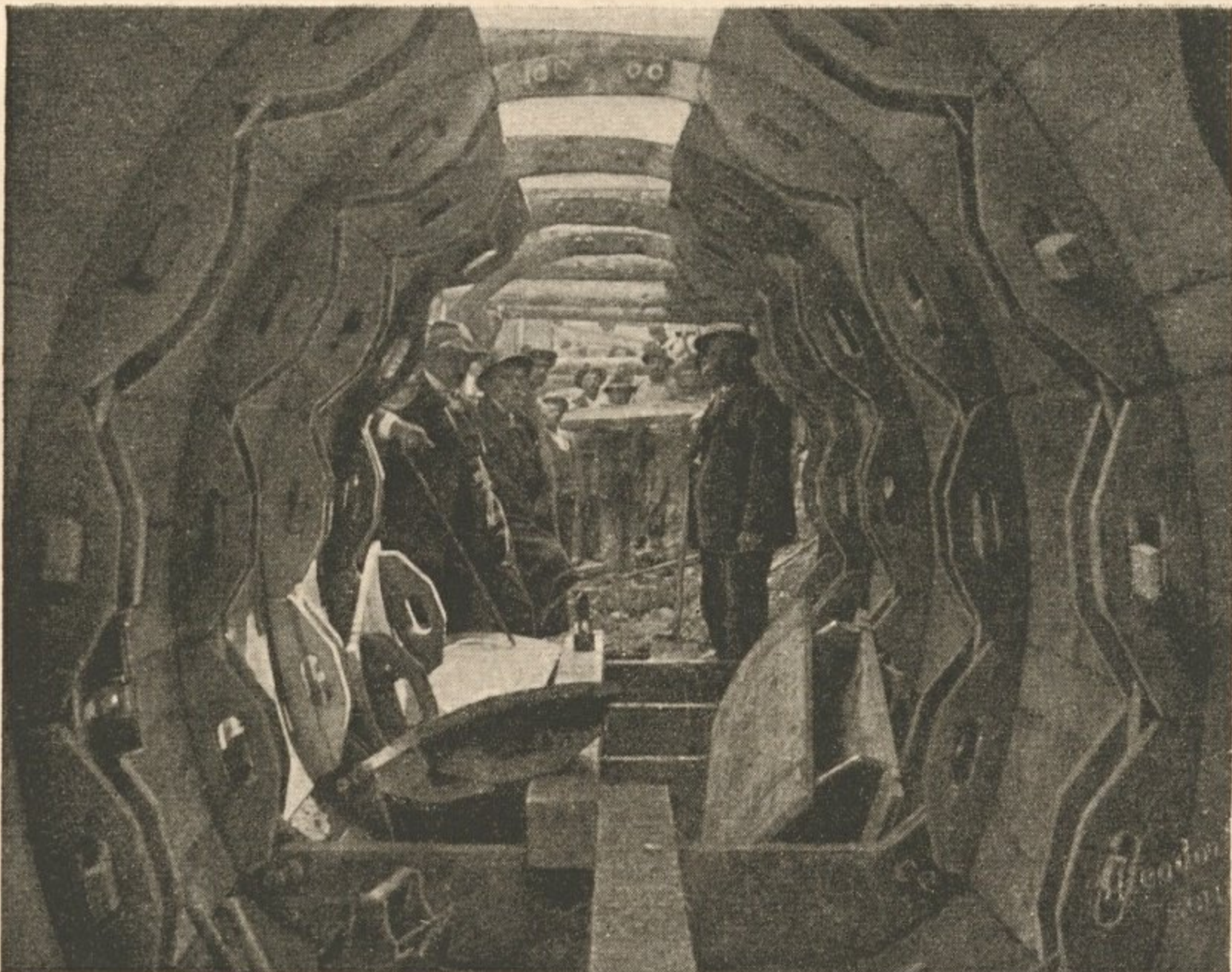
Nr. 68. Lehrbogen für den Einbau des Leitungskanals.
