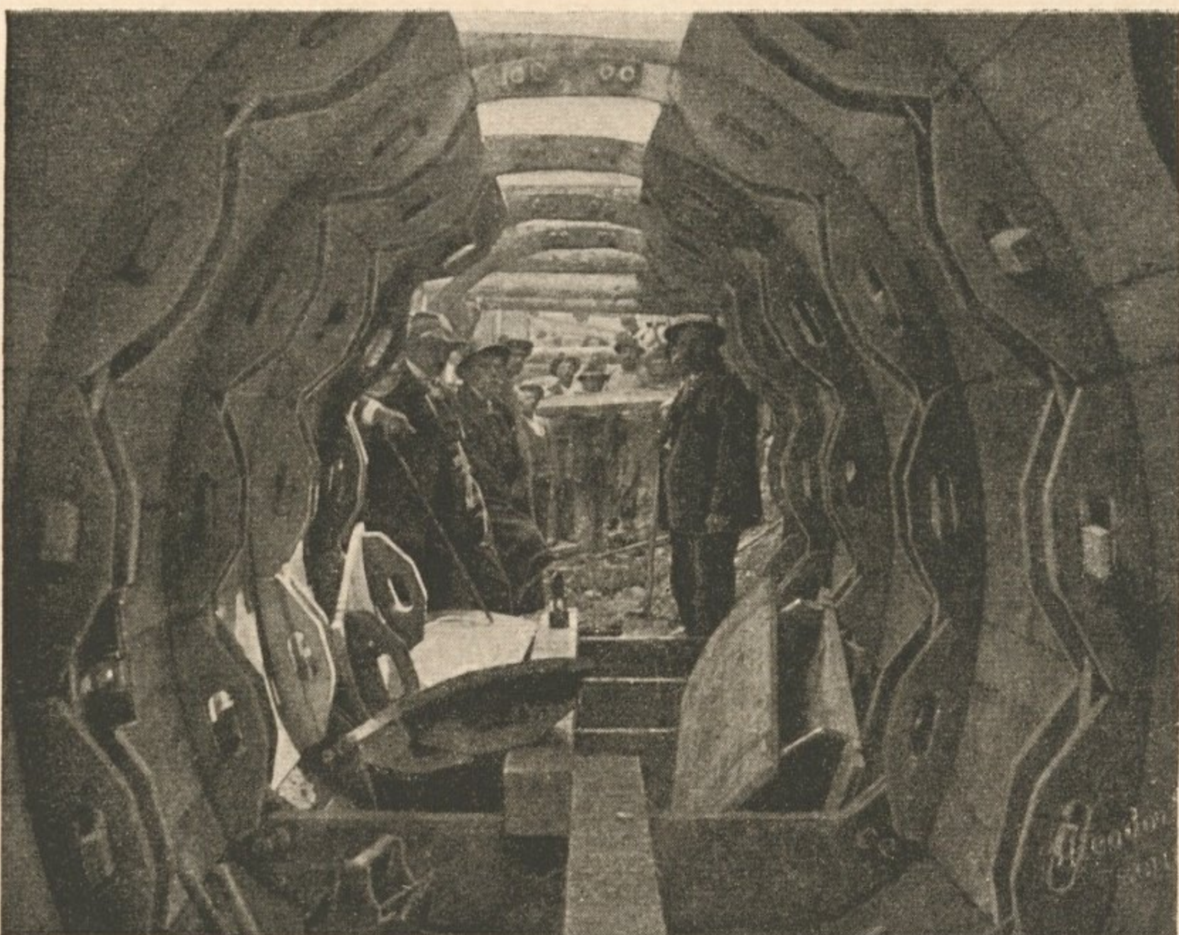
Nr. 68. Lehrbogen für den Einbau des Leitungskanals.
