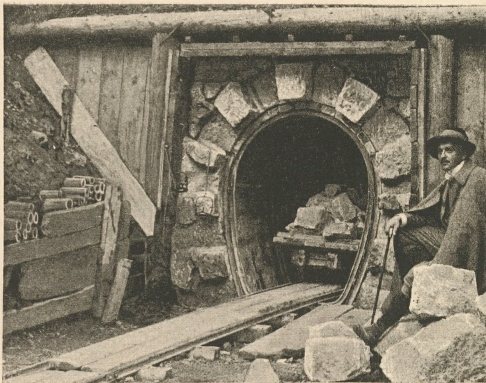
Nr. 69. Stolleneinwölbung im Bau.
