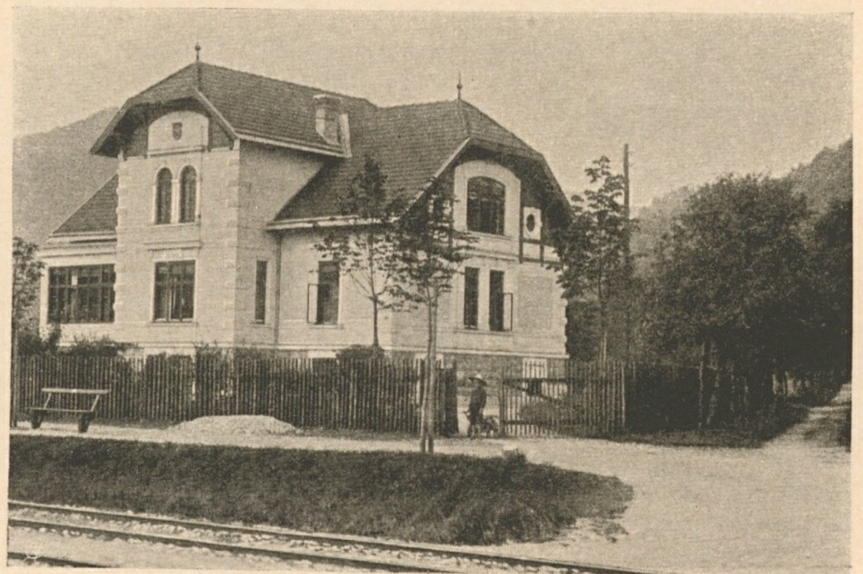
Nr. 73. Das neue Betriebsgebäude in Scheibbs.
