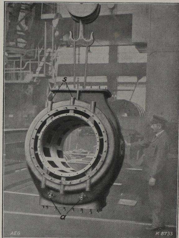
Doppeltwirkende Zweitakt-Dieselmachine, Bauart AEG-Hesselman,  $D = 680$ ,  $H = 1200$
