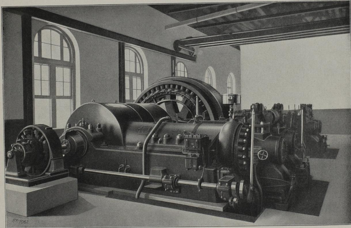
1000 PS Körting-Dieselmachine ohne Kompressor in einem Elektrizitätswerk
