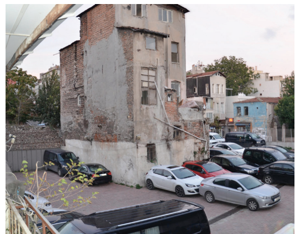
Abb.38: Blick nach Osten über den Bauplatz (Bestandsgebäude links)
