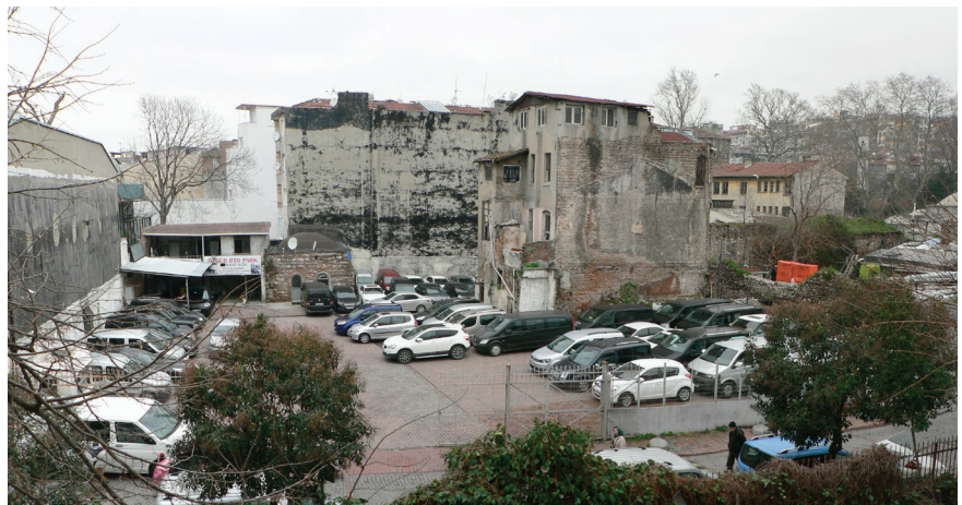
Abb.39: Blick nach Westen über den Bauplatz (Bestandsgebäude in der Mitte)
