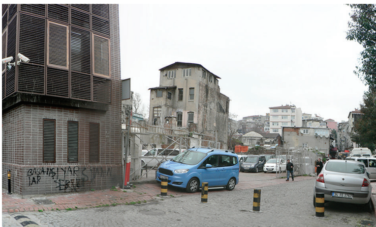
Abb.37: Im Süden anschließendes Wohngebäude (linker Bildrand) mit Blick auf den Parkplatz
