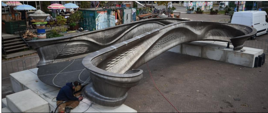
Abbildung 4: Additiv gefertigte Fußgängerbrücke der Firma MX3D (MX3D 2019)
