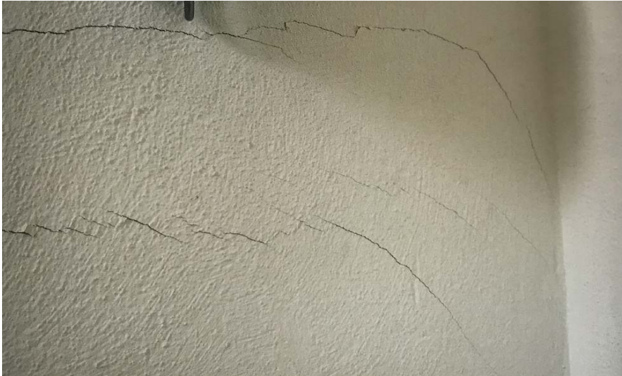
Bild 5-21: Schrägrisse durch Schubspannen 222
