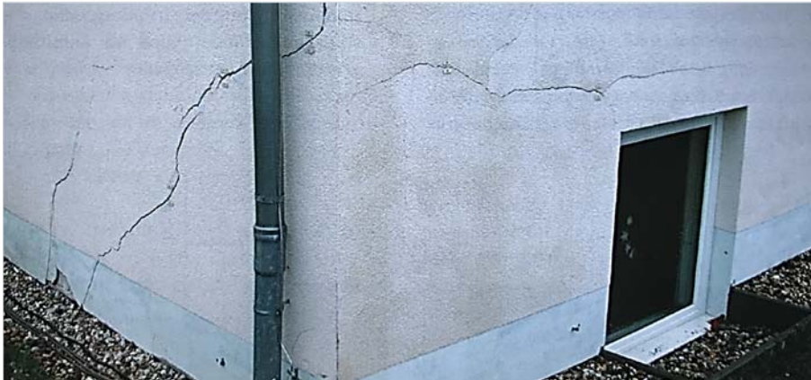
Bild 5-13: Setzungsrisse 208
