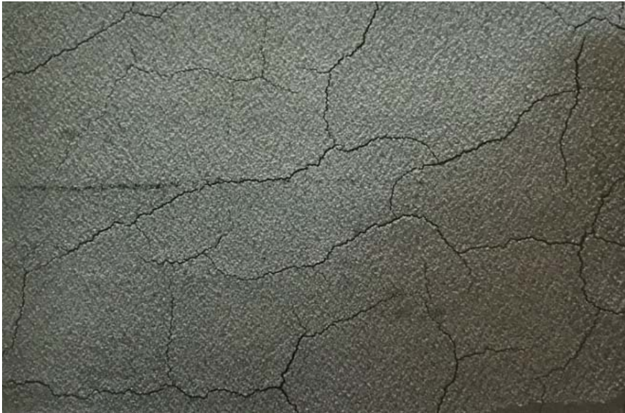
Bild 5-28: Schwindrisse 233
