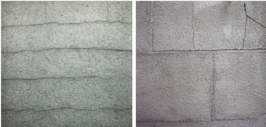
Bild 5-33: Stein-Putz-Risse 243
