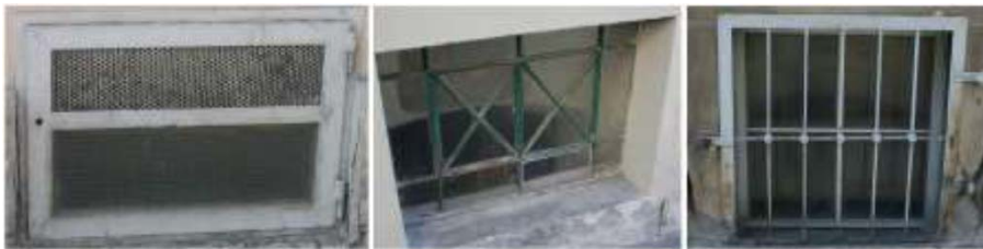
Bild 4-20: Ausführungsvarianten im Sockelbereich 86
