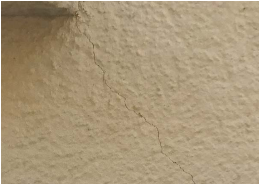
Bild 5-30: Kerbriss 238
