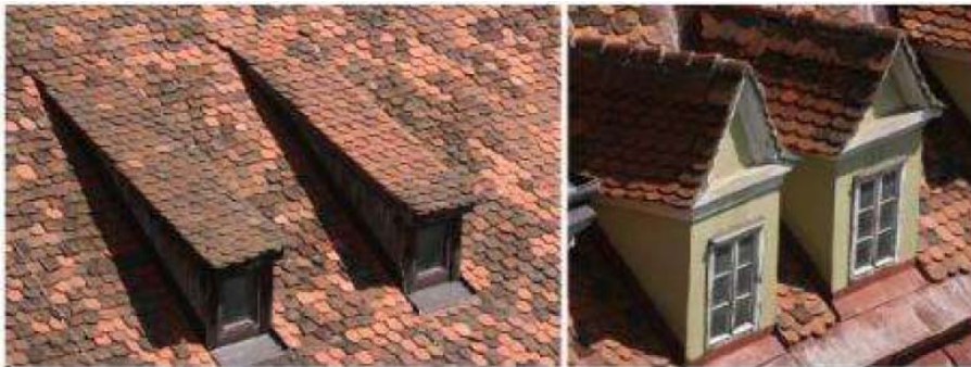
Bild 4-51: Schleppgaube (links) und Satteldachgaube (rechts) 145
