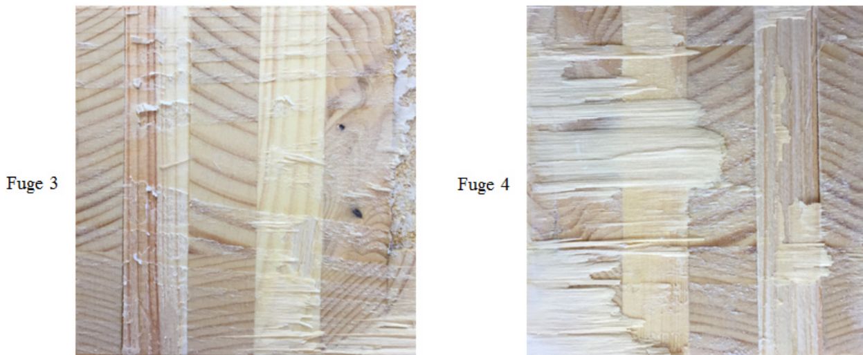
Abbildung 5.12: Delaminierungsanteil am aufgespaltenen Prüfkörper DQ-B-05 der Prüfserie A – Fuge 3 und 4
