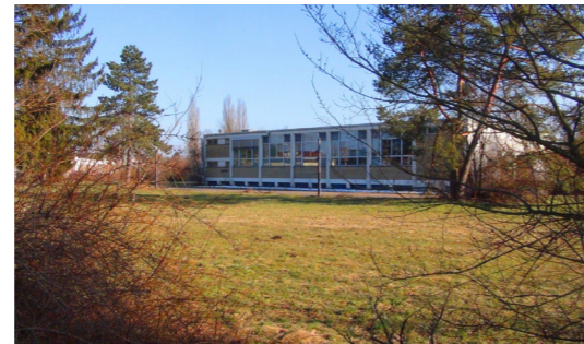
195 | Standpunkt 8: ehemaliges Unterkunftsgebäude (Nr. 3)
