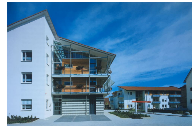
89 | Pflegeheim (vorne links) und Haus A (hinten rechts)
