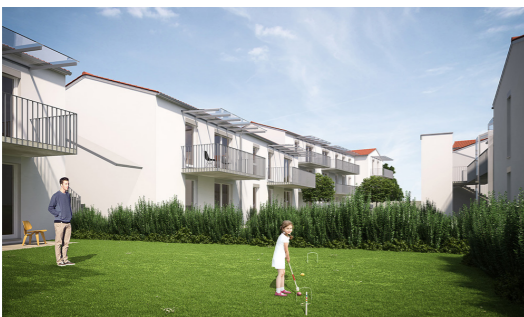
210 | Standpunkt 18: Render Wohnungen GWS, Baustart Herbst 2018
