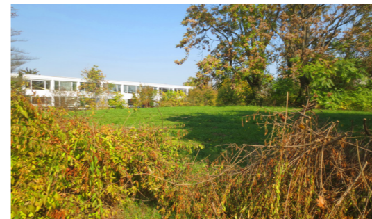
200 | Standpunkt 10: ehemaliges Unterkunftsgebäude, Ansicht Südwest
