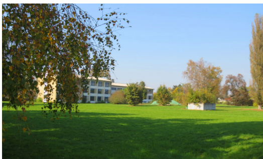
208 | Standpunkt 16: ehemaliges Unteraktsgebäude (Nr. 4)
