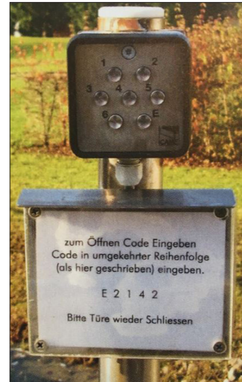
243 | Beispiel Gartentorsicherung Demenzbereich
