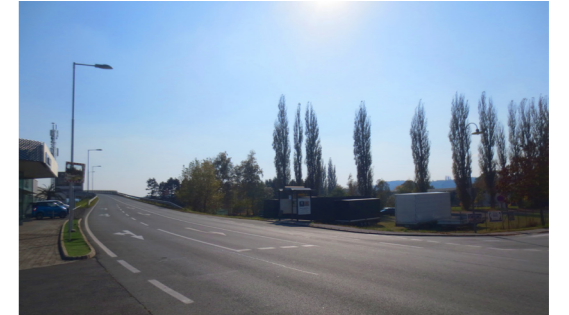
184 | Standpunkt 1: Marburgerstraße, Blick Richtung Süden
