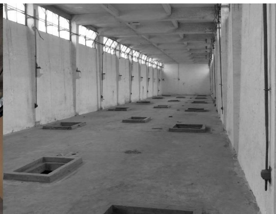
Abb.37: Bild der bestehender Befüllungshalle
