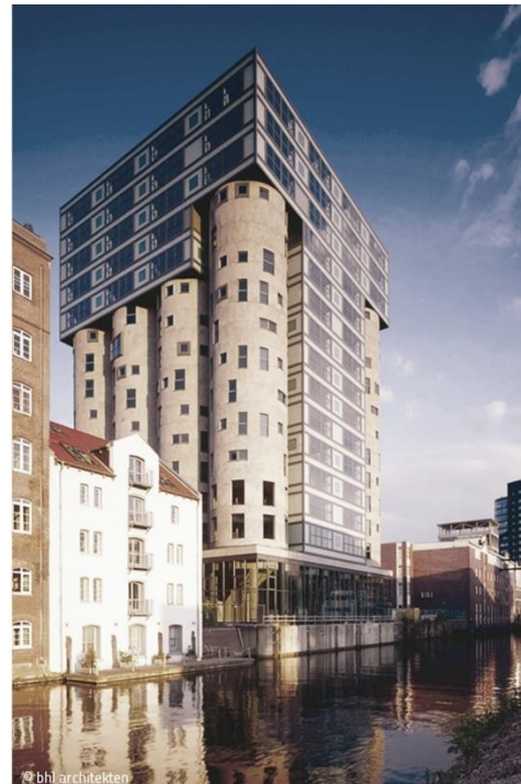
Abb.32: Das Silo vom Kanal aus gesehen
