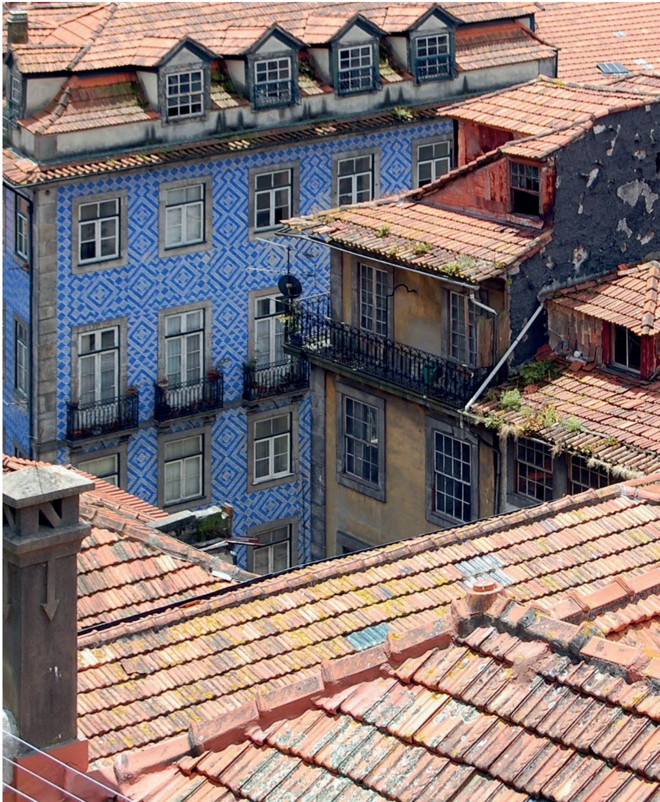
Abb.I.16. Detailaufnahme von Portos Dachlandschaft.
