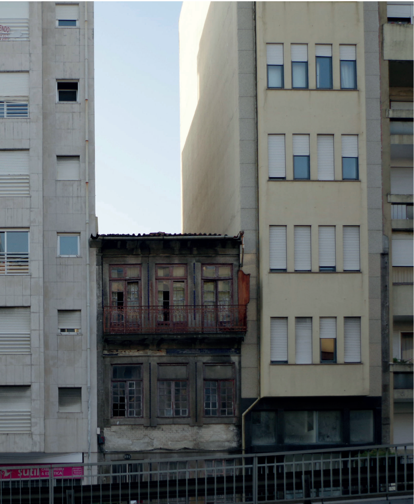
In der Nähe von Trindade, ein Hauptverkehrsknotenpunkt der Stadt.
