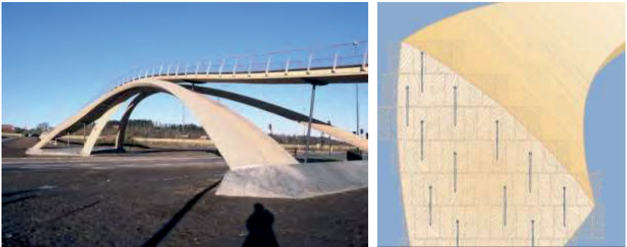
Abbildung 2-6: Leonardo da Vinci Brücke, Norwegen (li) und Schraubpressverklebung im Detail (re)
