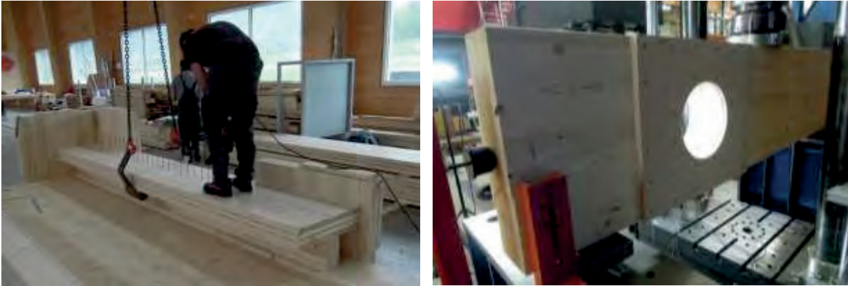
Abbildung 1-1: Schraubpressverklebung einer Rippenplatte (li) und Prüfung eines schraubpressverklebten Verstärkung eines kreisrunden Durchbruchs in einem Brettschichtholz-Träger (re)
