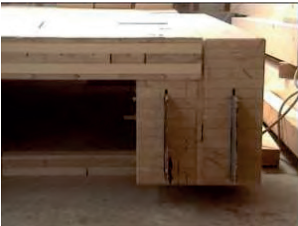
Abbildung 2-5: Querschnitt eines mittels Schraubpressverklebung hergestellten Brückendeckes einer Fußgänger- und Radwegbrücke (li), Rippendecke aus schraubpressverklebten BSH-BSP-Bauteilen im Bautechnikzentrum der TU Graz (re)
