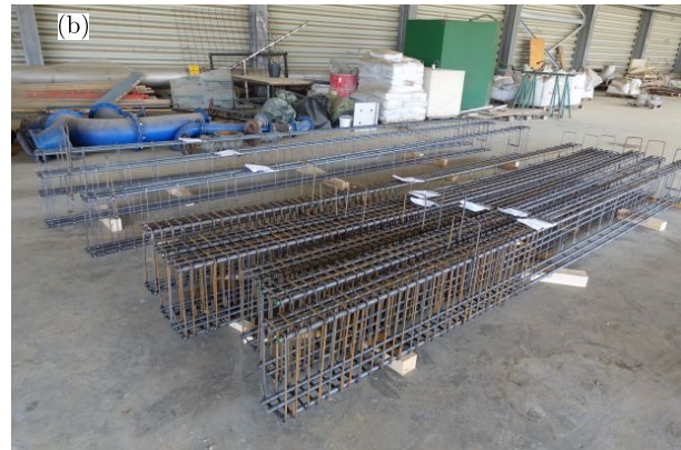
Abb. 4.4.: (a) Herstellung der Bügel (b) Bewehrungskörbe
