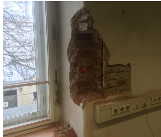
Abbildung 2-5 – Mauerwerkserkundung
