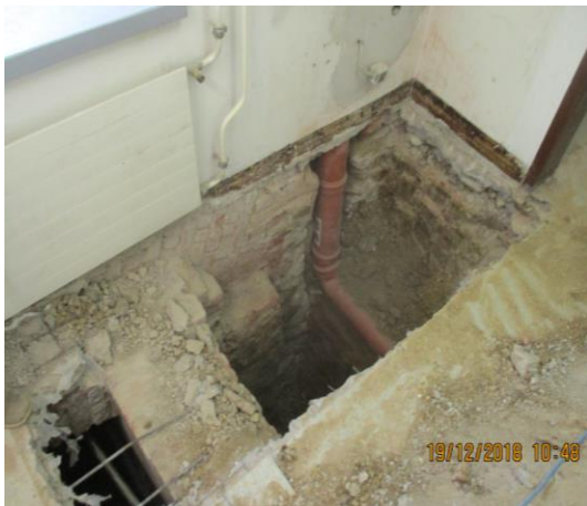
Abbildung 2-4 – Fundamenterkundung
