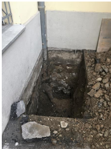
Abbildung 5-18 – Beispielfoto Fundamentaufschluss
