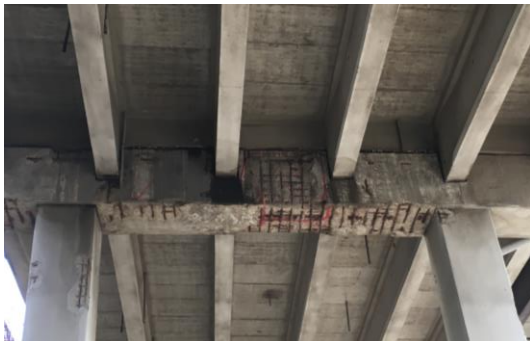
Abbildung 2-6 – Brückentragwerkssanierung
