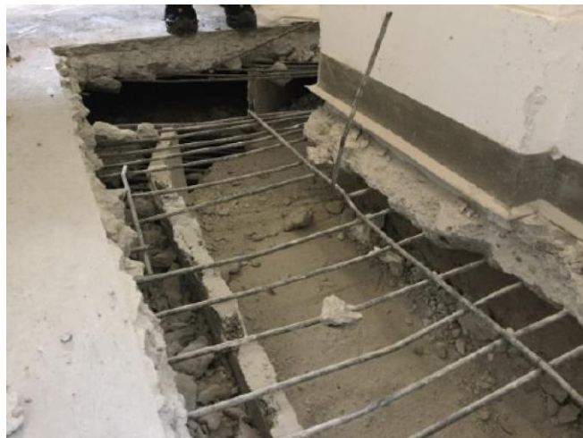
Abbildung 5-19 – Beispielfoto Deckenöffnung
