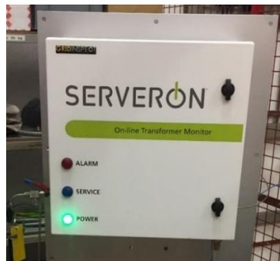
Bild 21: Online DGA-Monitoringsystem des Typs TM8 der Firma Qualitrol/Serveron
