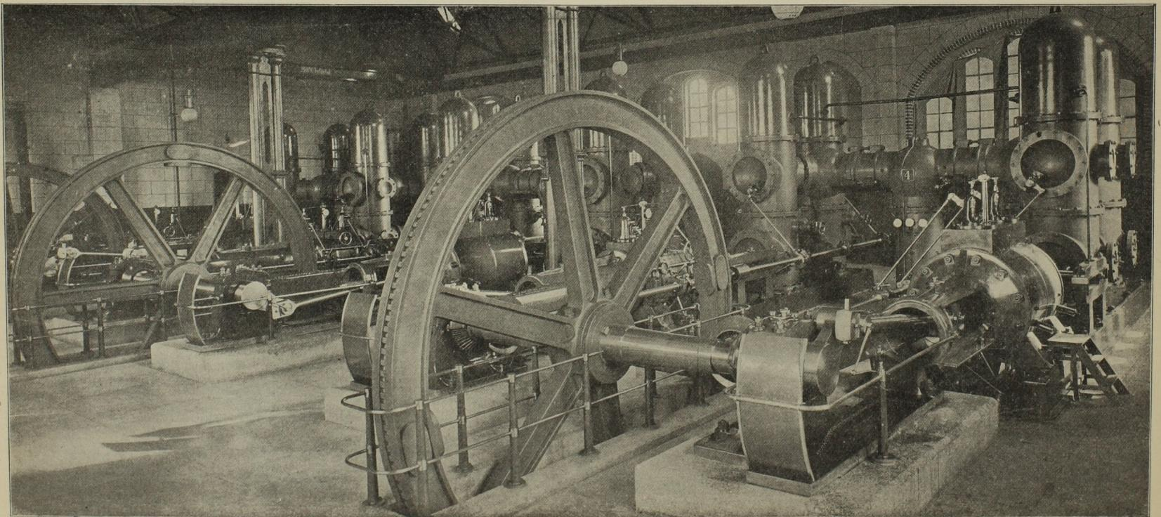
Abb. 41. Pumpmaschinen der Berliner Wasserwerke Lichtenberg C.
