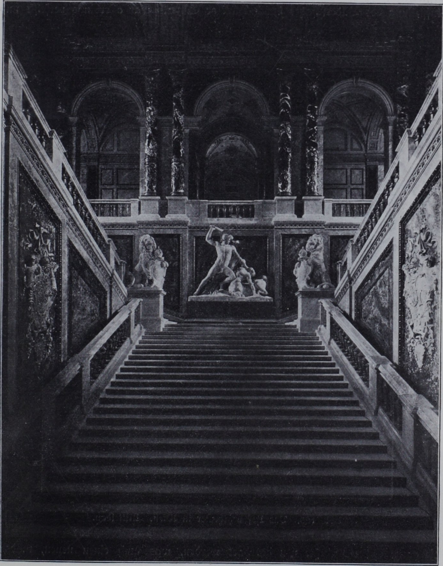
Abb. 102. Das Treppenhaus des Hofmuseums in Wien.
